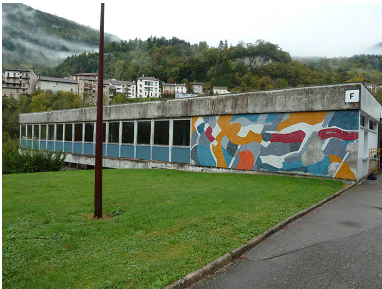
Vue générale, avant restauration du bâtiment.
