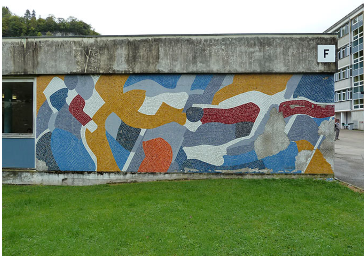
Vue générale, avant masquage par façade.
