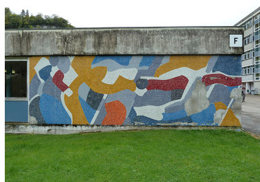
Vue générale, avant masquage par façade. Phot. Philippe Mairot IVR43_20143900794NUC4A
