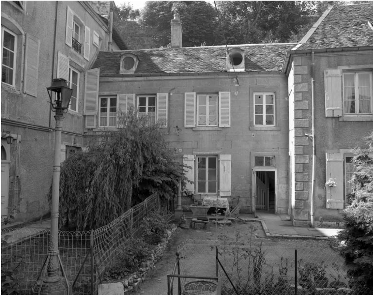
Logement annexe gauche : façade antérieure de face.
