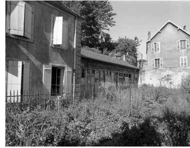
Le bûcher de trois quarts gauche. Phot. Yves Sancey IVR43_19897000368X
