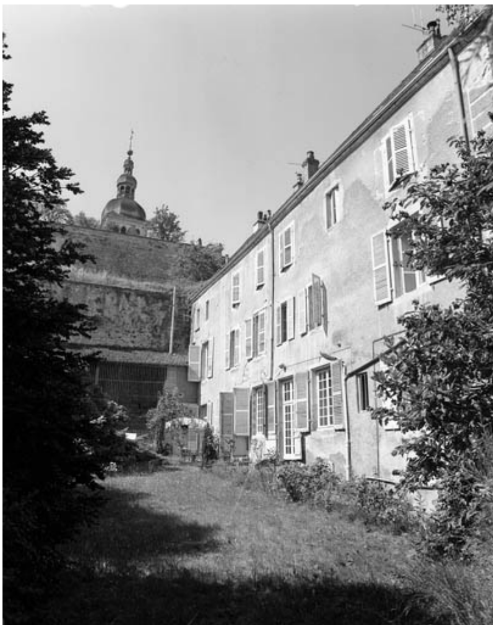
Façade postérieure de l'hôtel.
