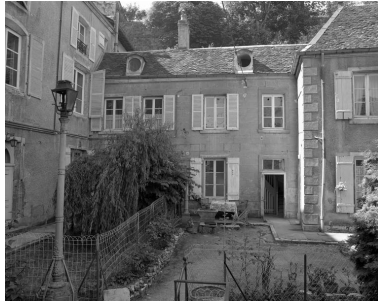
Logement annexe gauche : façade antérieure de face. Phot. Yves Sancey IVR43_19897000367X
