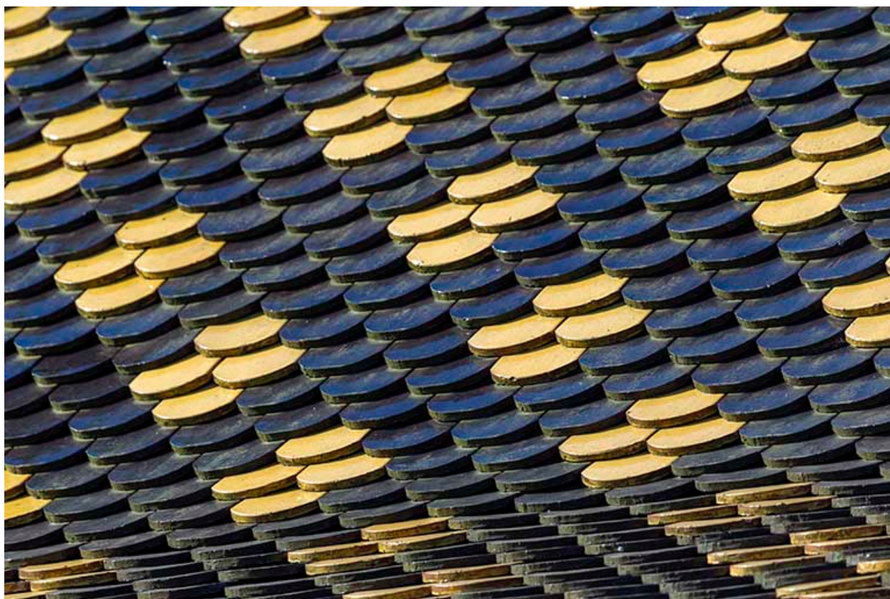
Tuiles vernissées de la toiture.
