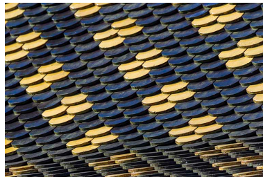
Tuiles vernissées de la toiture.
