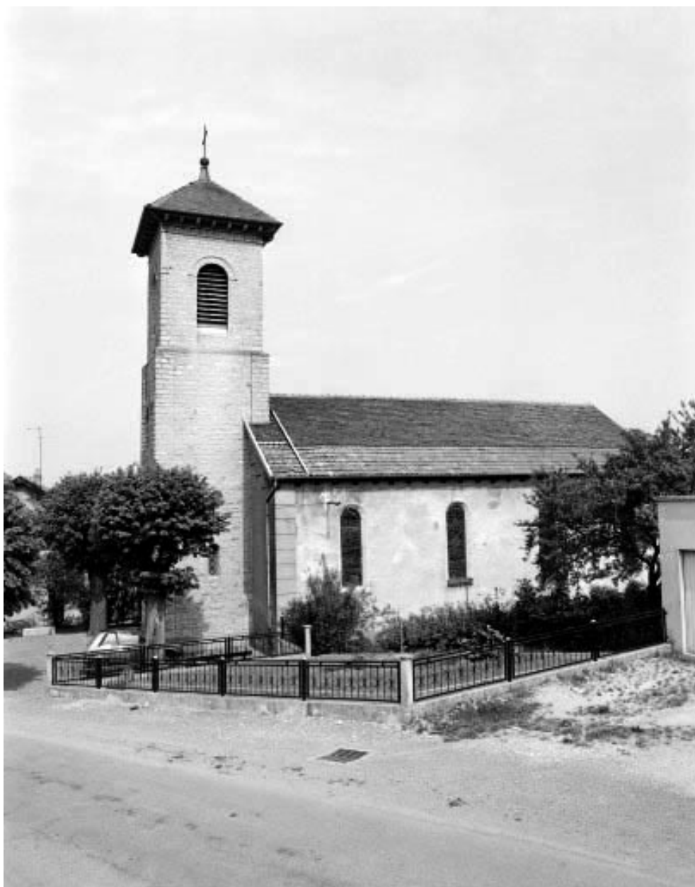
Façade latérale droite.
