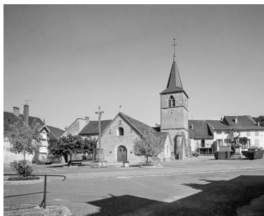
Eglise paroissiale de la Nativité-de-la-Vierge. Phot. Yves Sancey IVR43_19843900203V
