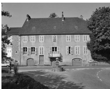
Maison de vigneron située rue du Jura.
