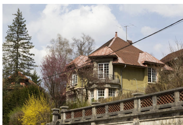
Logement patrimonial : vue d'ensemble, depuis le sud. Phot. Yves Sancey IVR43_20103900181NUC2A
