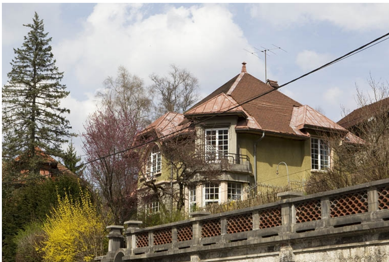
Logement patronal : vue d'ensemble, depuis le sud.
