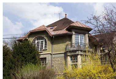
Logement patrimonial. Phot. Yves Sancey IVR43_20103900180NUC2A
