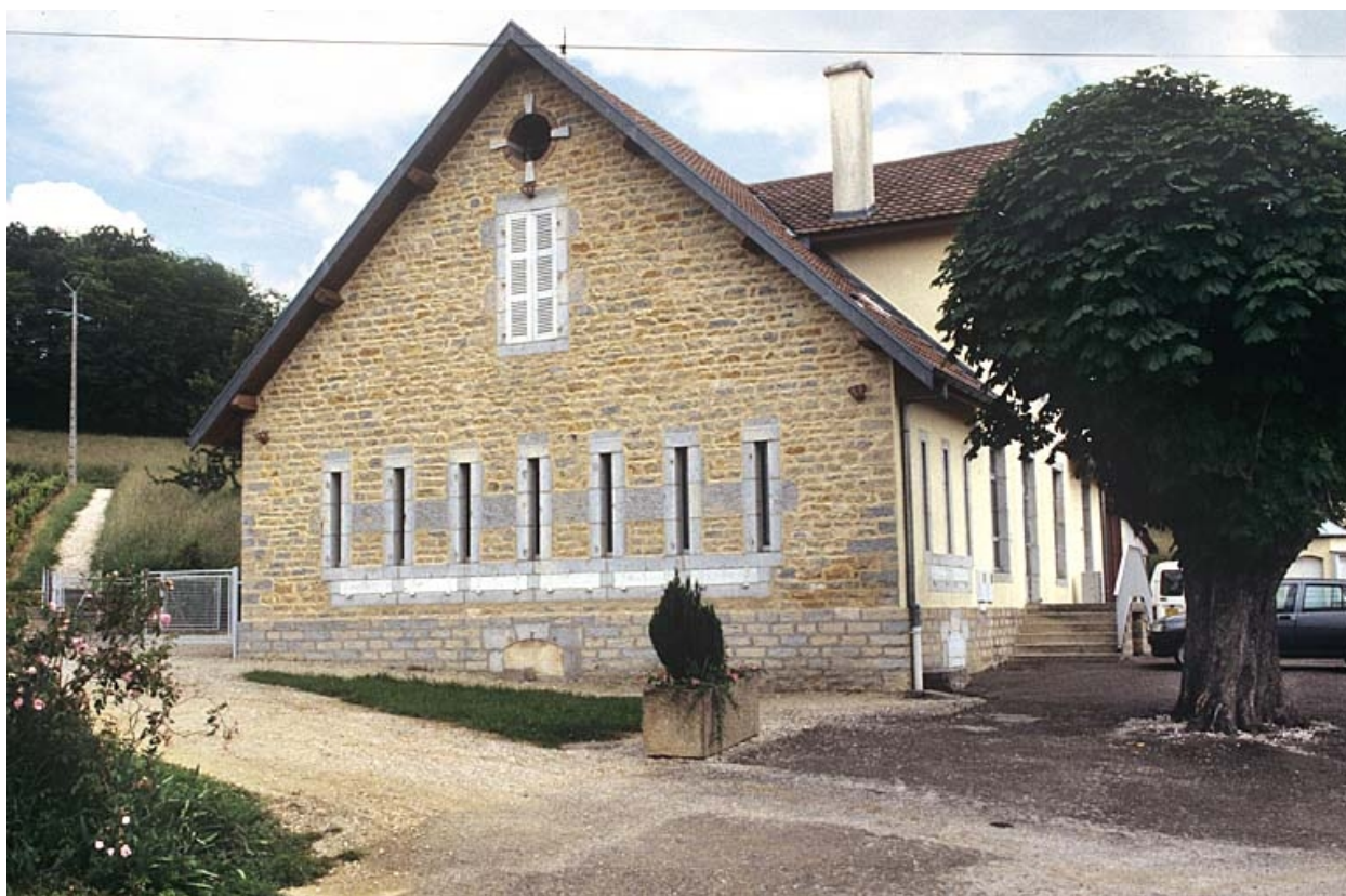
Façade latérale gauche (chambre à lait).
