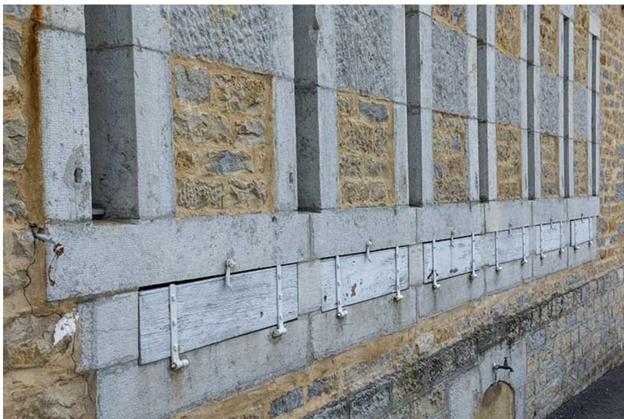
Vue rapprochée des baies.
