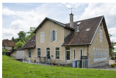
Vue de trois quarts arrière. Phot. Sonia Dourlot IVR43_20203900086NUC4A
