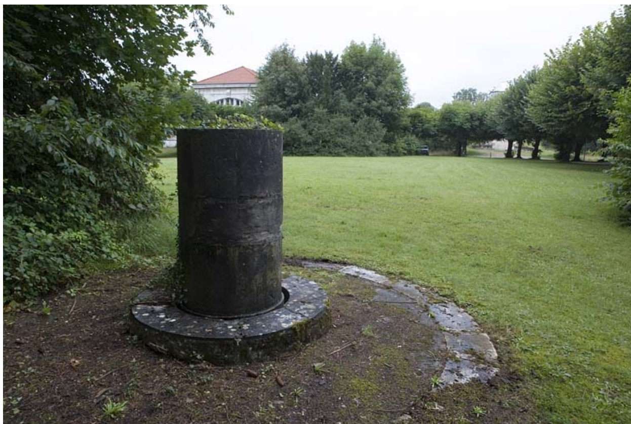
Vestiges de la coupole et du pilier.
