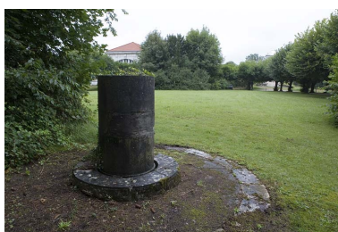
Vestiges de la coupole et du pilier.
