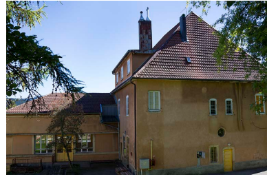
Façade postérieure. Phot. Yves Sancey
