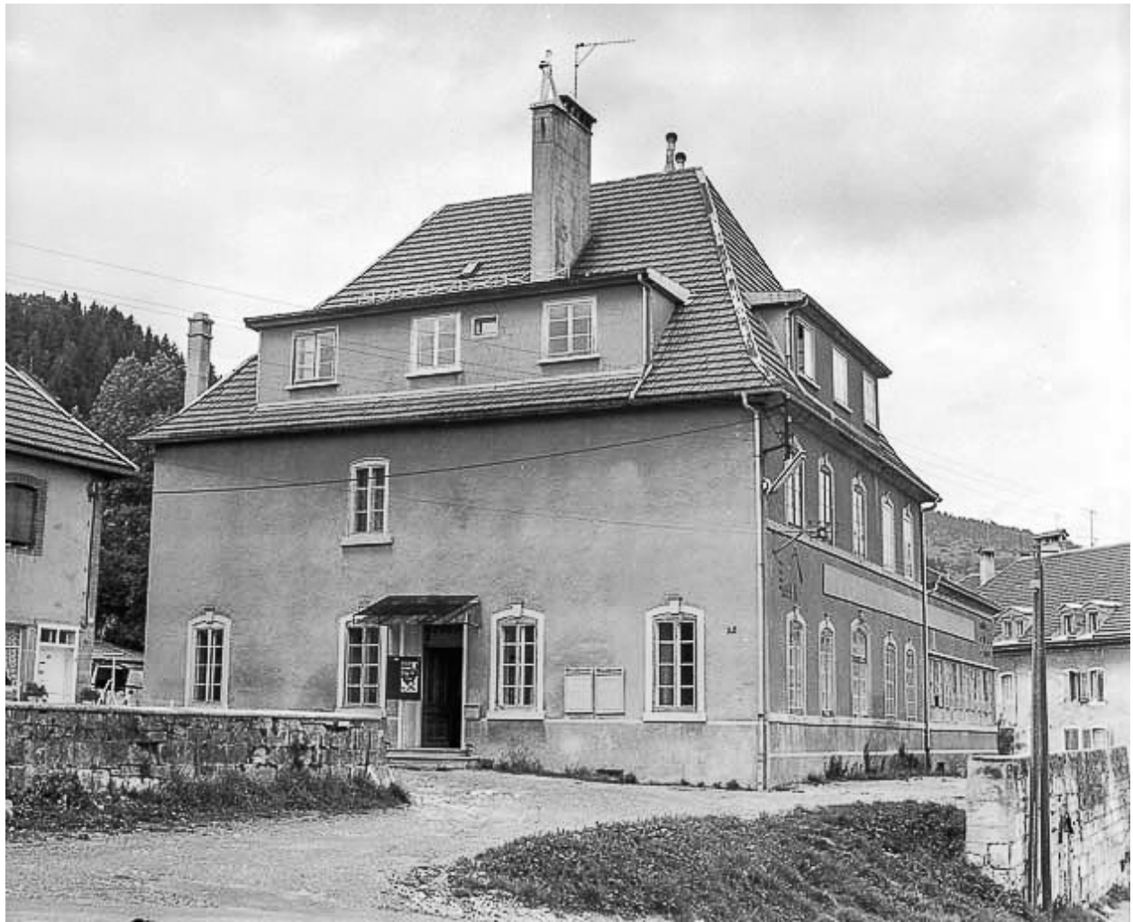
Vue d'ensemble depuis l'ouest, en 1976.
