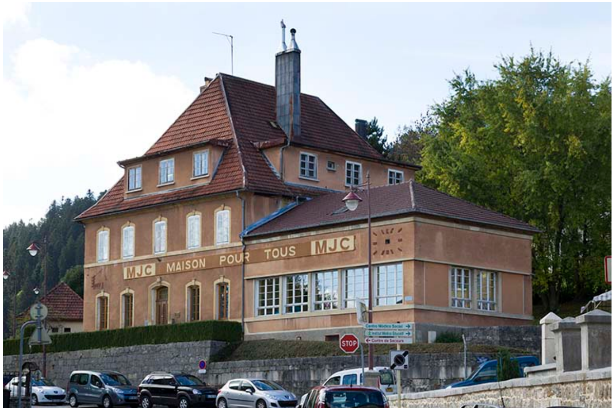
Façades antérieure et latérale droite.
