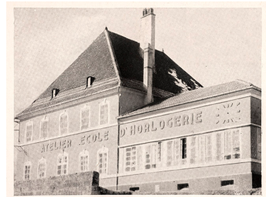
Atelier Ecole d'Horlogerie, 1949. Autr. Curtit, Phot. Sonia Dourlot IVR43_20142500334NUC4A
