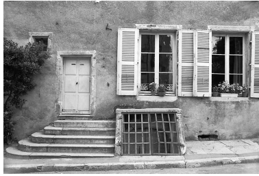
Détail du rez-de-chaussée. Phot. Bernard Lardière IVR43_19817000746Z
