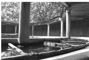
Vue de détail : compartimentage du bassin pour les lessives individuelles. Phot. Jean-Marie NEPASUTILISERBaverel IVR43_19807000583Z
