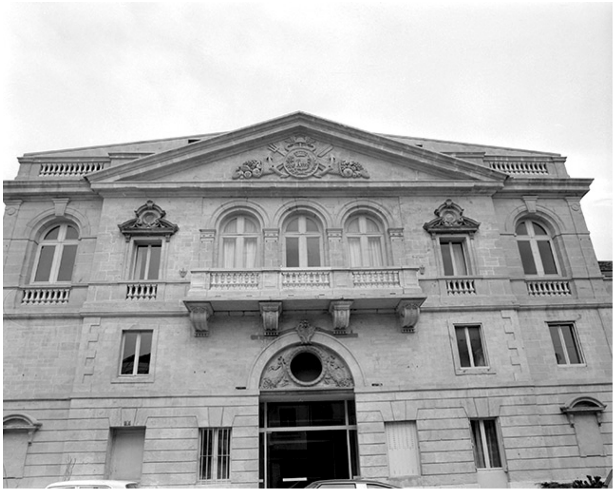
Façade antérieure. Corps central, vue d'ensemble.
