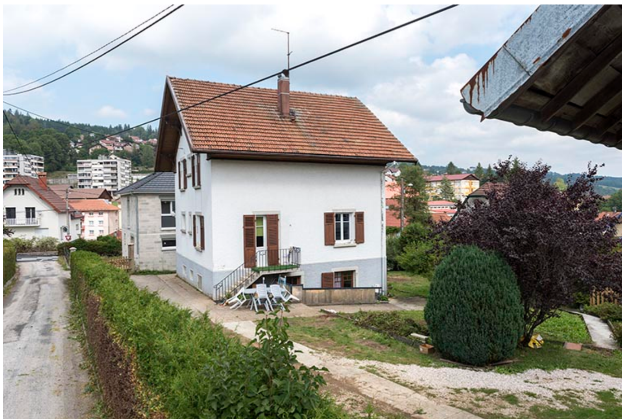
Maison : façades antérieure et latérale droite.
