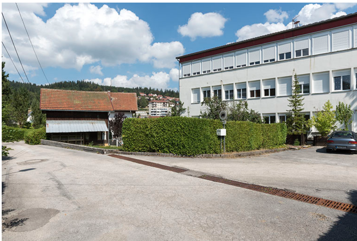
Bûcher, maison et usine (façade latérale droite).
