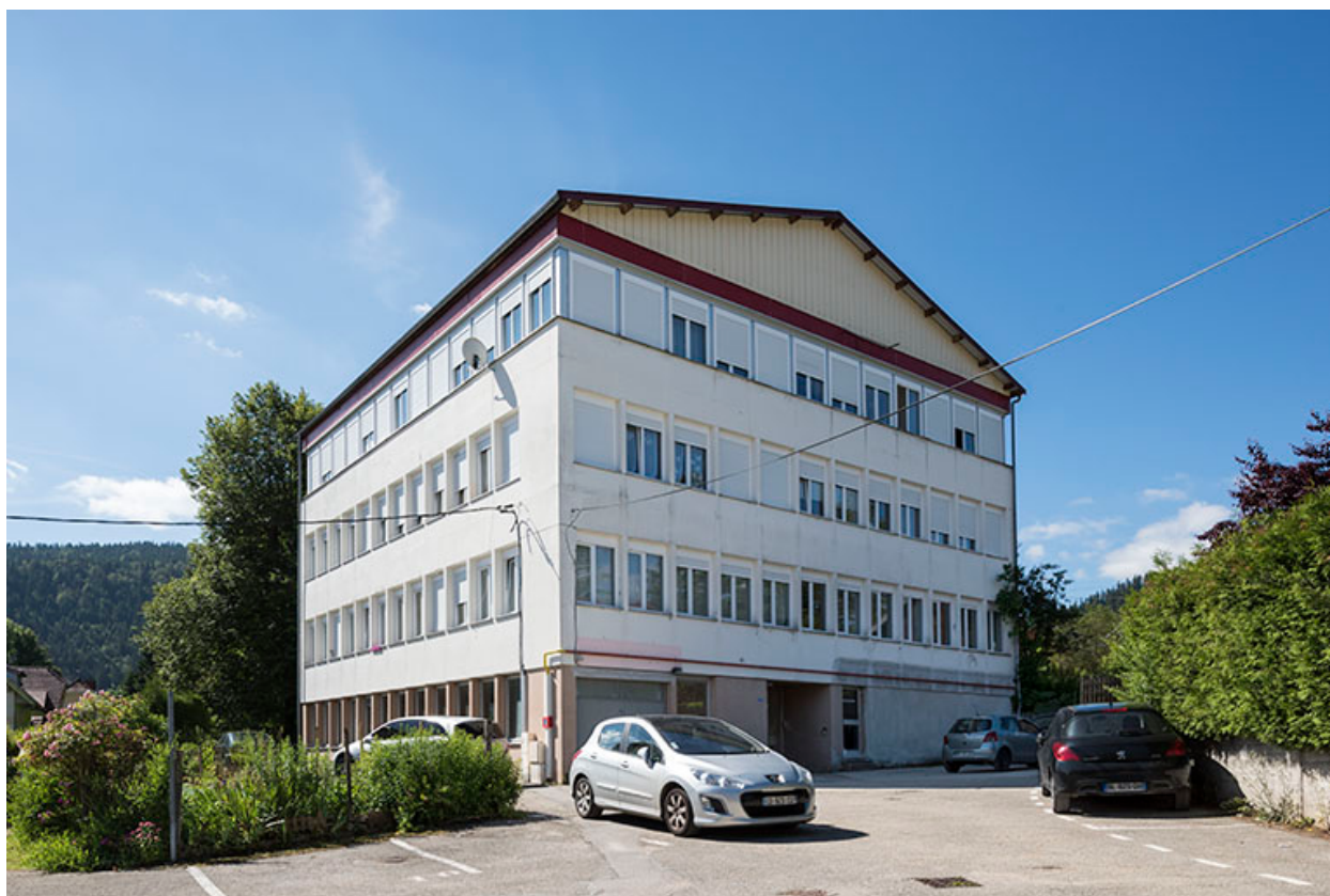
Usine : façades antérieure et latérale gauche.
