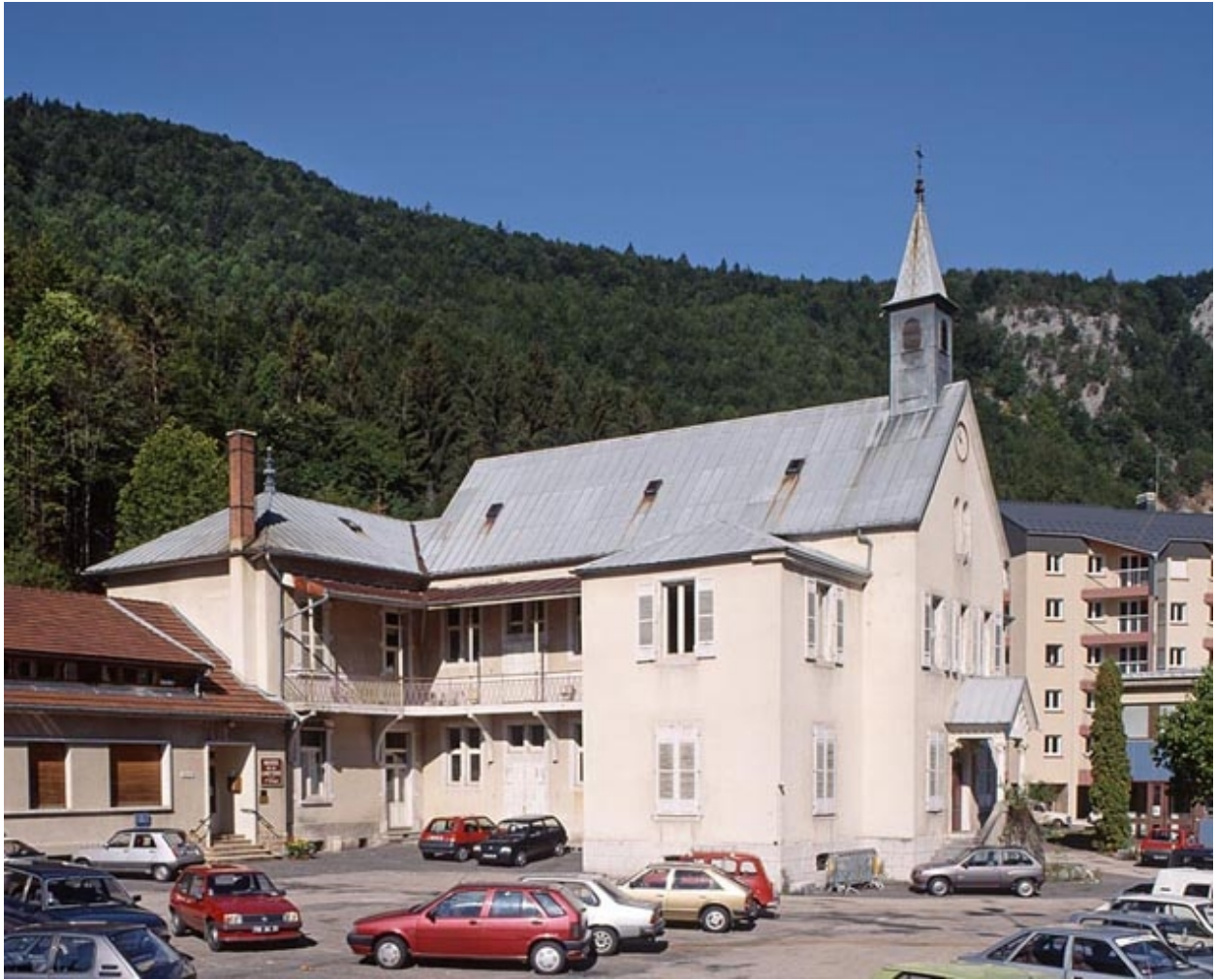
Façades antérieure et latérale gauche.
