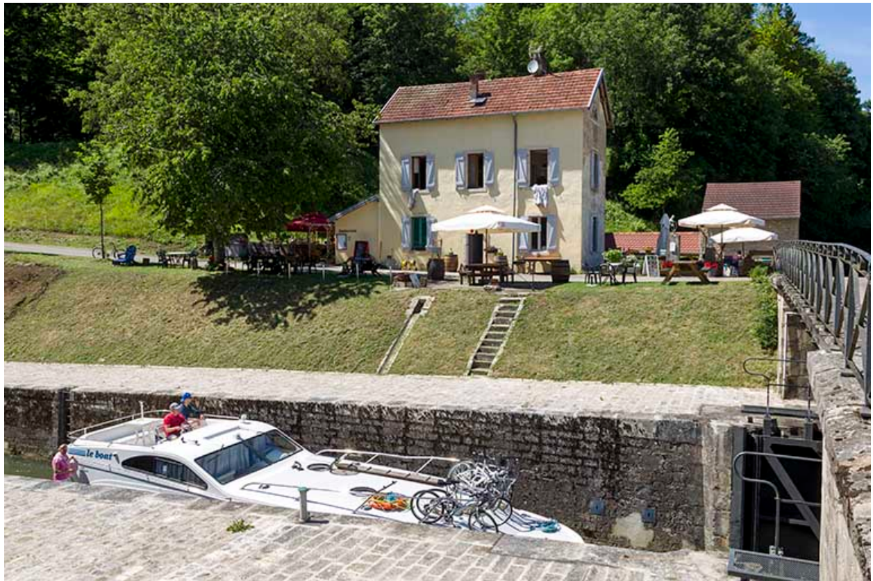
Entrée amont du tunnel Saint-Albin.
