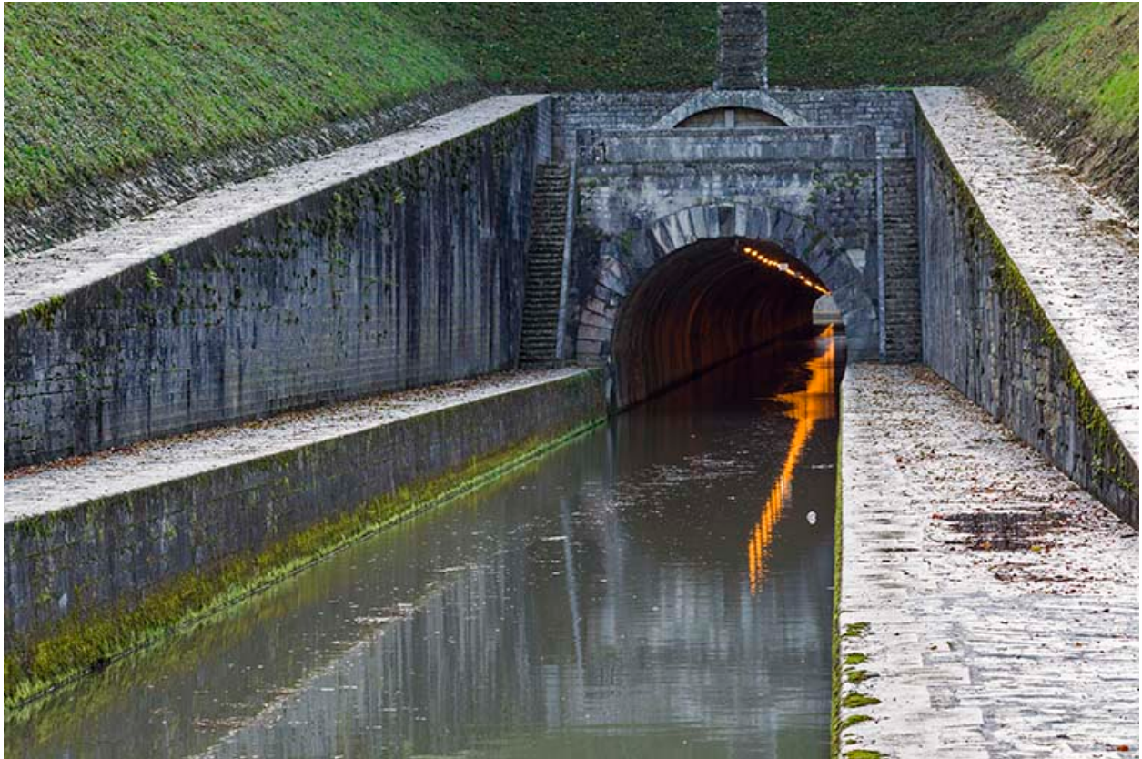
Le tunnel de Saint-Albin.
