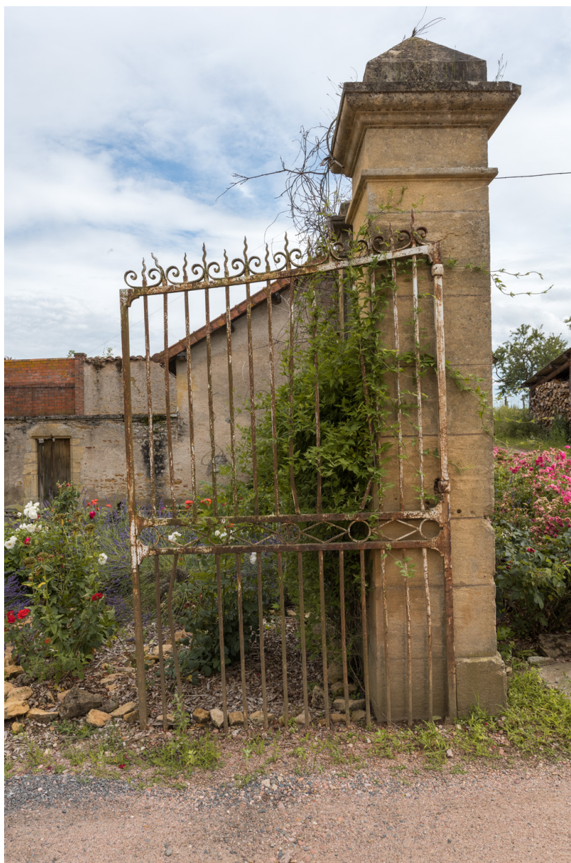
Détail du portail d'entrée de la demeure.
