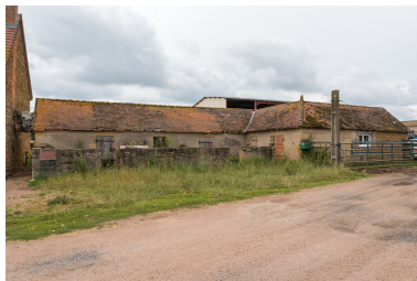
Dépendances (soue, etc.). Phot. Pierre-Marie Barbe-Richaud IVR26_20187100213NUC4A
