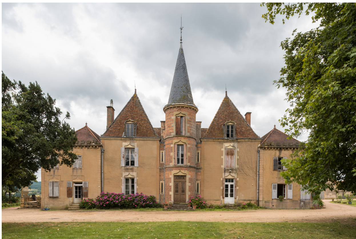
Façade postérieure de la demeure.
