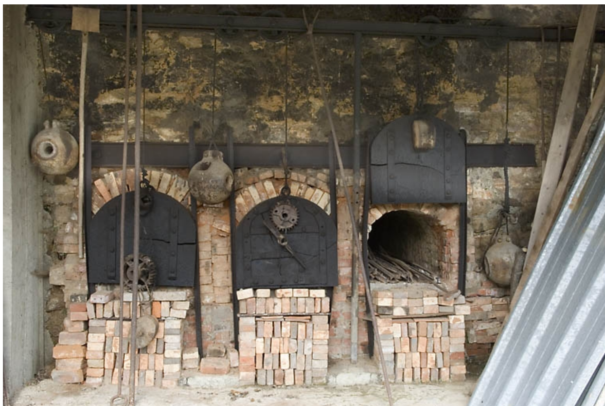
Façade est du four. Gueules de charge.
