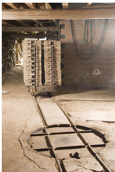
Wagonnet à plateaux sur voie Decauville. Phot. Jérôme Mongreville IVR43_20087000778NUC2A
