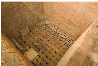
La sole vue depuis la partie supérieure du four. Phot. Jérôme Mongreville IVR43_20087000797NUC2A
