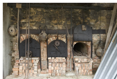
Façade est du four. Gueules de charge. Phot. Jérôme Mongreville IVR43_20087000761NUC2A
