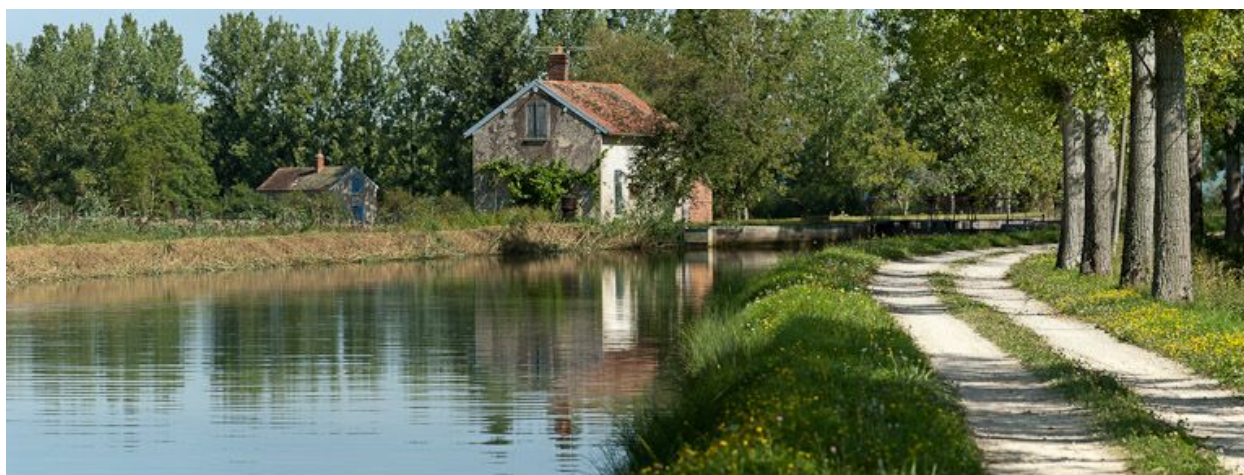
Vue du site d'écluse depuis l'amont.
