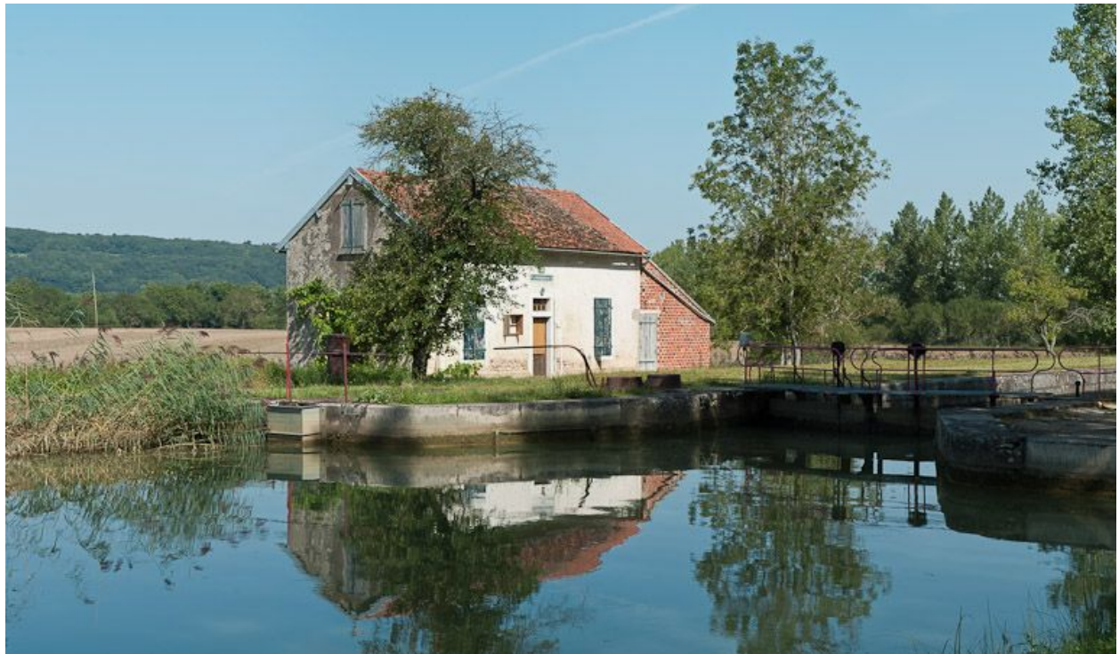
Vue du site d'écluse depuis l'amont.
