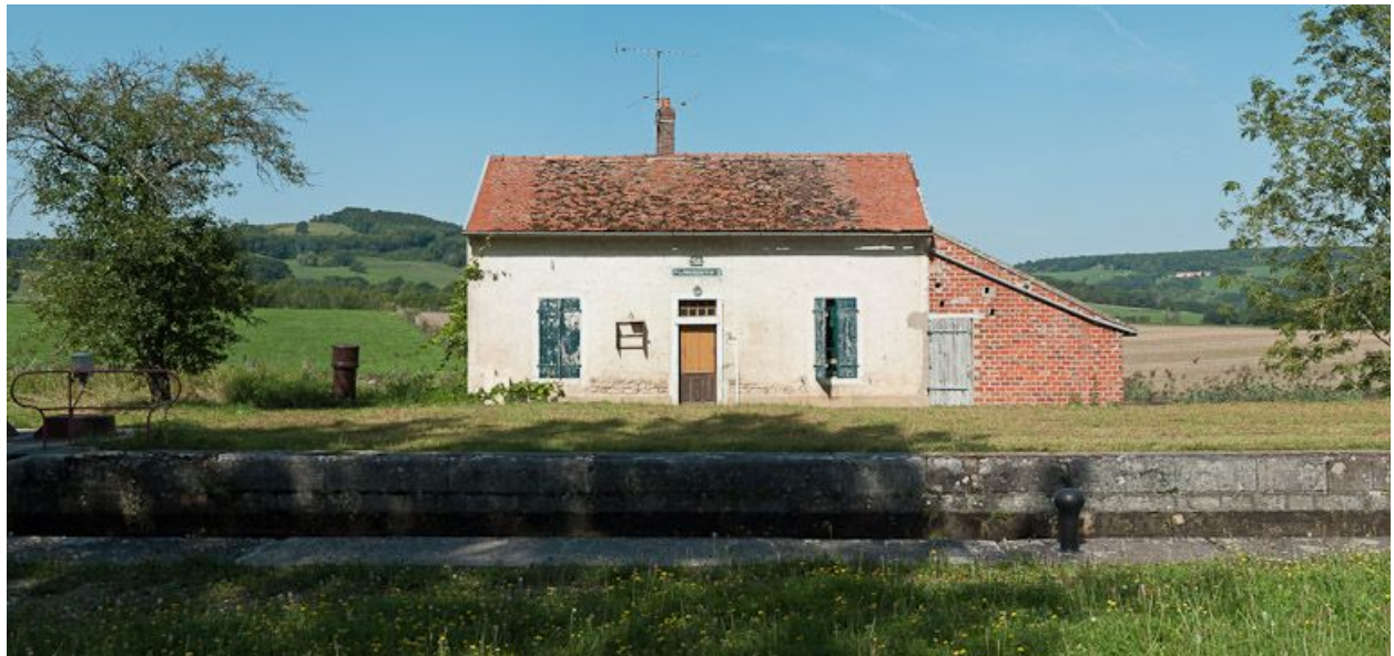
Vue de face de la maison éclusière.
