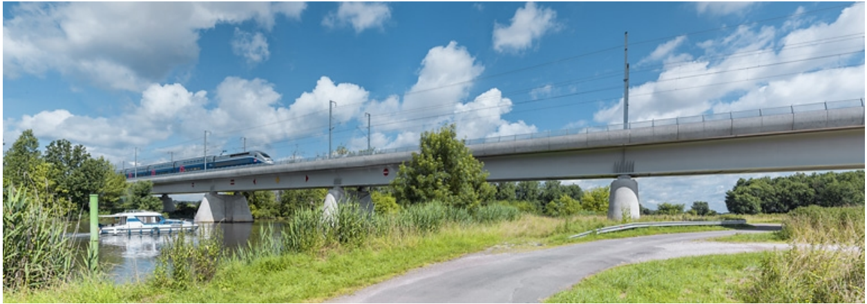
Vue d'ensemble avec TGV franchissant la Saône.
