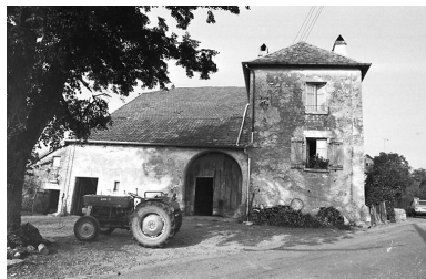
Vue d'ensemble. Phot. Bernard Lardière IVR43_19797000312Z
