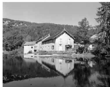
Vue d'ensemble depuis l'amont. Phot. Yves Sancey IVR43_19973901422X
