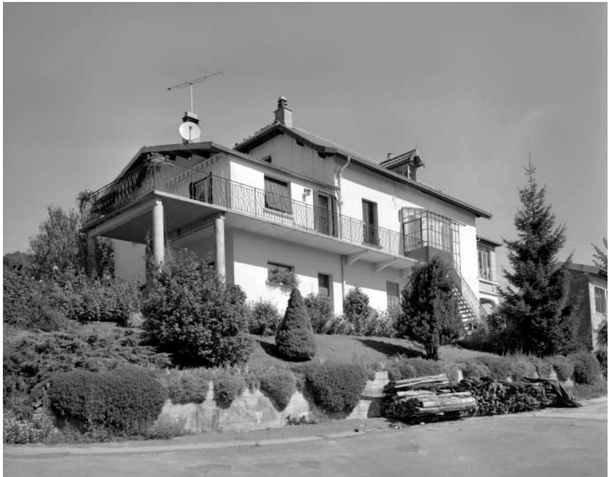
Vue en contre plongée du logement patronal.
