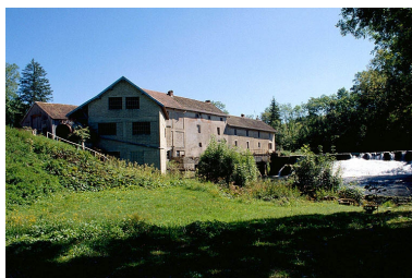
Façades postérieures vues de trois quarts gauche. Phot. Yves Sancey IVR43_19973901416ZA
