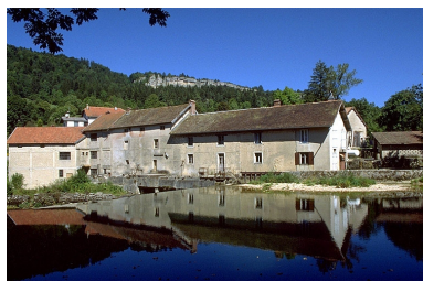
Façades sur rivière. De gauche à droite : magasin industriel, atelier de fabrication et logement ouvrier. Phot. Yves Sancey IVR43_19973901420ZA
