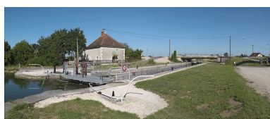
Vue d'amont. Phot. Thierry Kuntz IVR26_20112103017NUC4A
