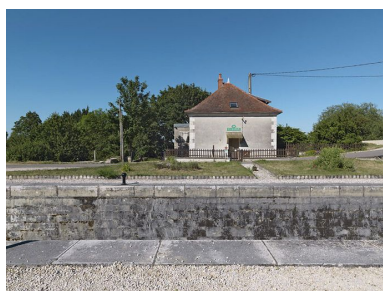
Maison éclusière vue de face. Elle ne présente pas de fenêtre de ce côté, ce qui n'est pas conforme au modèle de cette série. Phot. Thierry Kuntz IVR26_20112103020NUC4A
