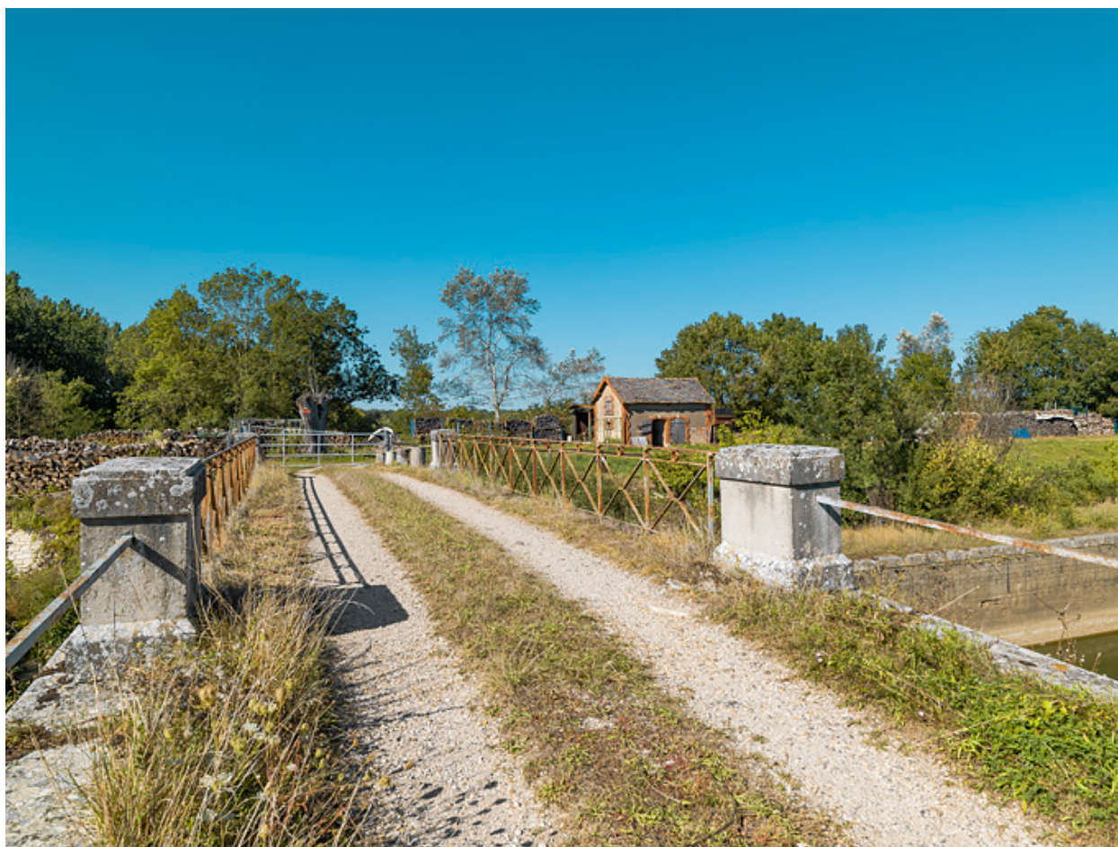
Vue d'ensemble du pont sur l'écluse.
