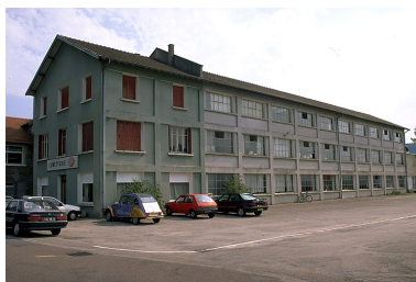
Bureau et atelier de fabrication (ouest). Phot. Yves Sancey IVR43_19973901344ZA
