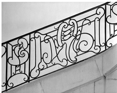
Pilastre et panneau de la 1ère volée. Phot. Jérôme Mongreville IVR43_19913900405V
