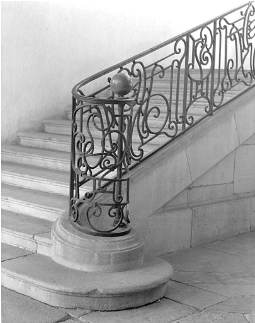
Départ de la rampe.
