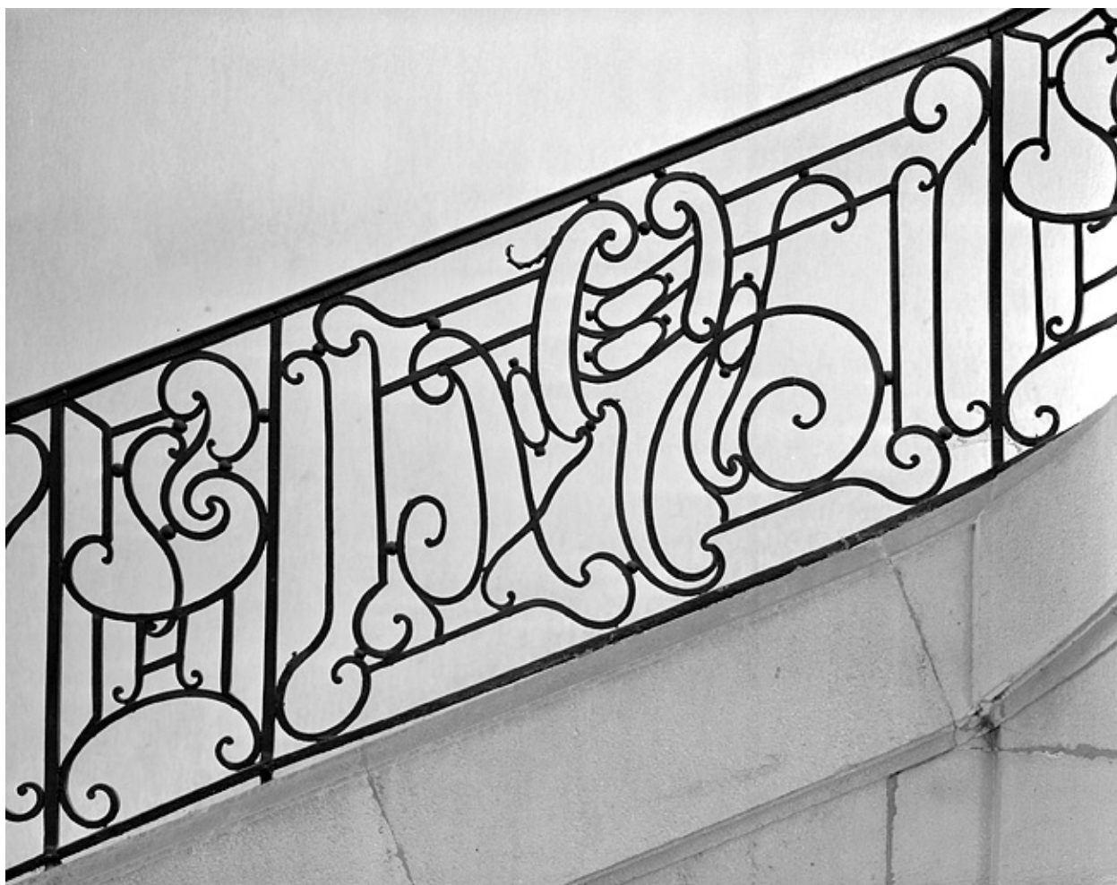
Pilastre et panneau de la 1ère volée.
