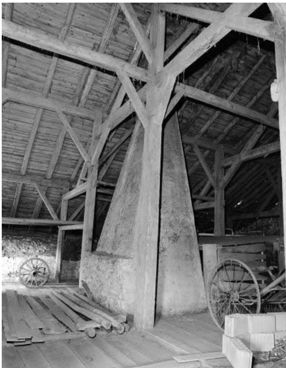
Charpente et conduit de cheminée.
