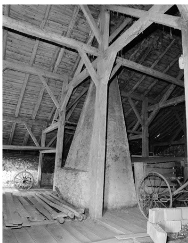
Charpente et conduit de cheminée. Phot. Dominique Dominguez IVR43_19792500273X
