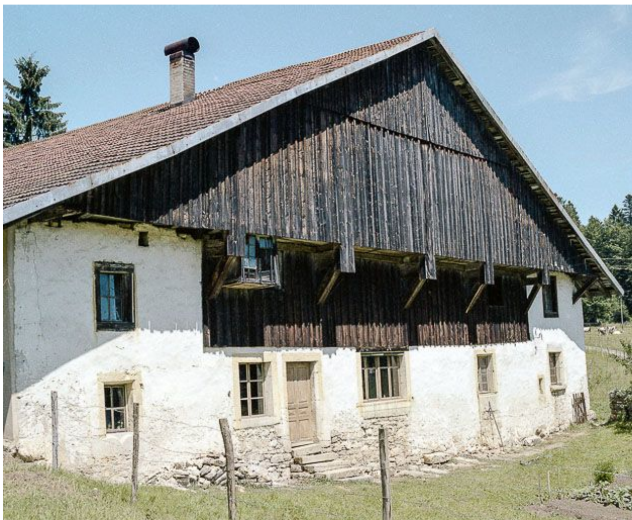
Façades antérieure et latérale droite.
