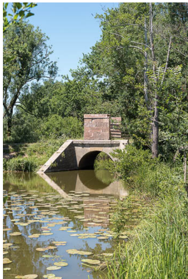
Vue du pont.
