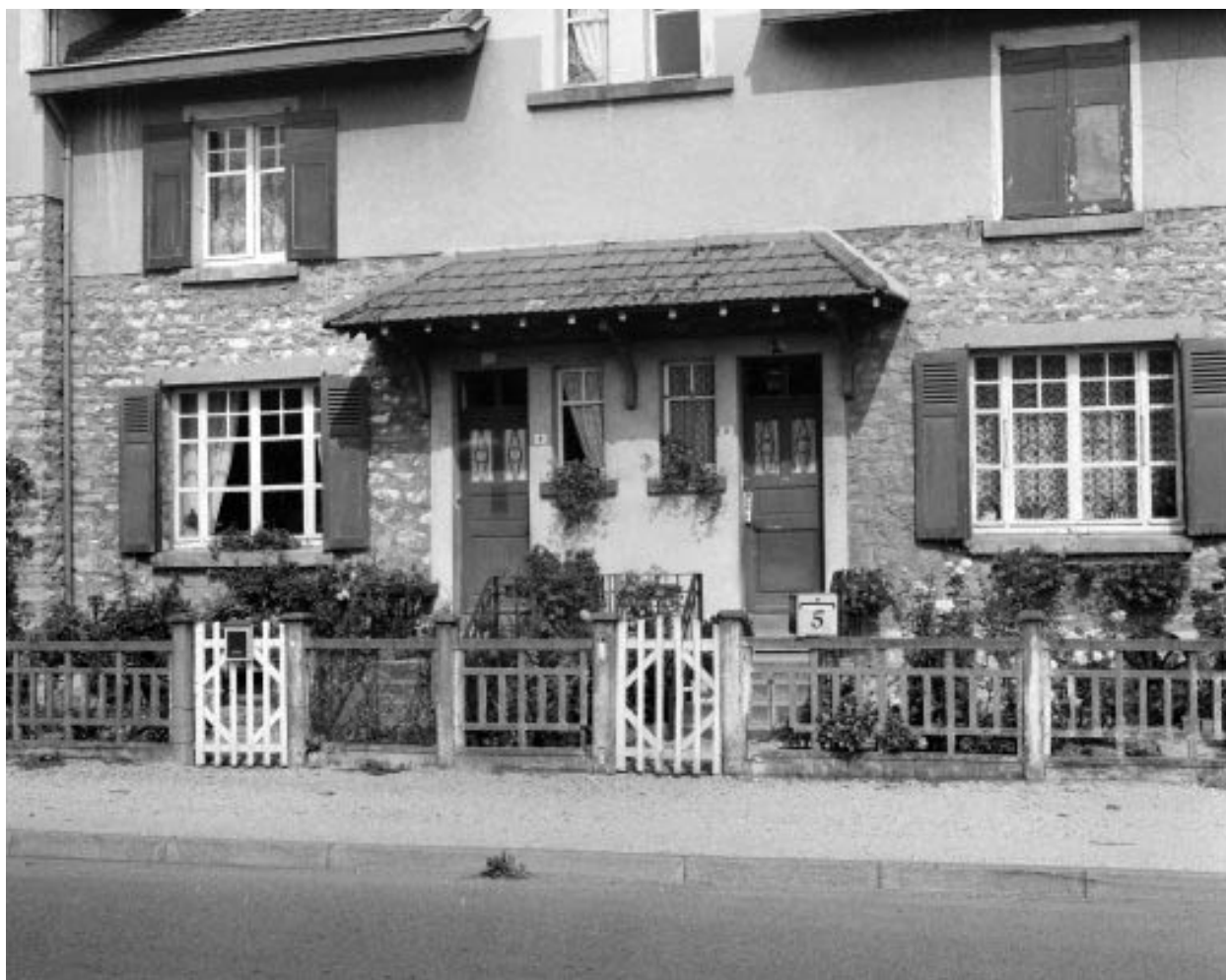
Façade antérieure, détail.
