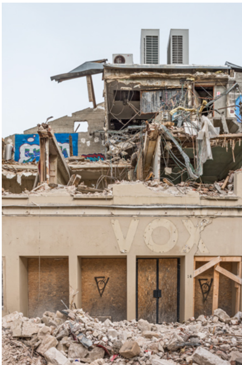
Sens, 14 rue Victor Guichard : cinéma Vauban puis Vox. Démolition le 22 mars 2023.
