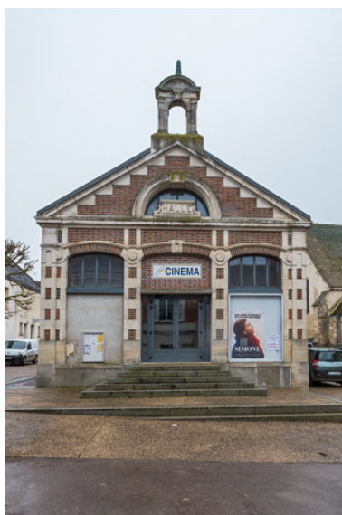
Champignelles, quartier de l'Eglise : halle puis cinéma (étudié). Phot. Pierre-Marie Barbe-Richaud IVR26_20238900041NUC4A
