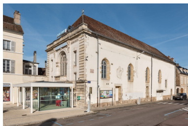
Avallon, 1 rue du Maréchal Foch : chapelle des capucins puis théâtre, actuellement cinéma le Vauban (étudié).
