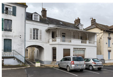
Brienon-sur-Armançon, 8 place Emile Drominy : ancien cinéma Palace. Phot. Pierre-Marie Barbe-Richaud IVR26_20238900597NUC4A
