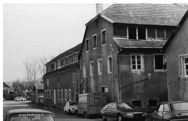
Vue des bâtiments depuis l'ouest. Phot. Raphaël Favereaux, Autr. Cohen (Photographe) IVR43_20122501363NUC2A
