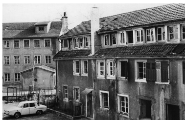
Logements ouvriers (?). Phot. Raphaël Favereaux, Autr. Cohen (Photographe) IVR43_20122501366NUC2A
