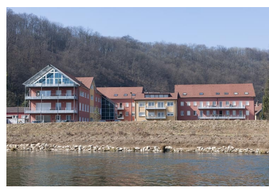
Vue d'ensemble depuis l'est. Phot. Jérôme Mongreville
