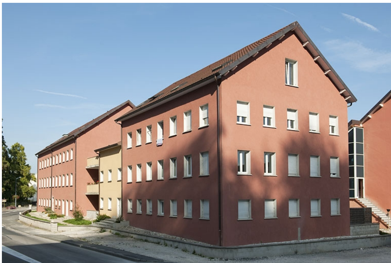
Ateliers de fabrication vus depuis le sud-ouest.
