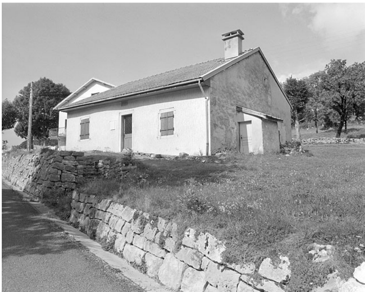
Façade antérieure et face droite.
