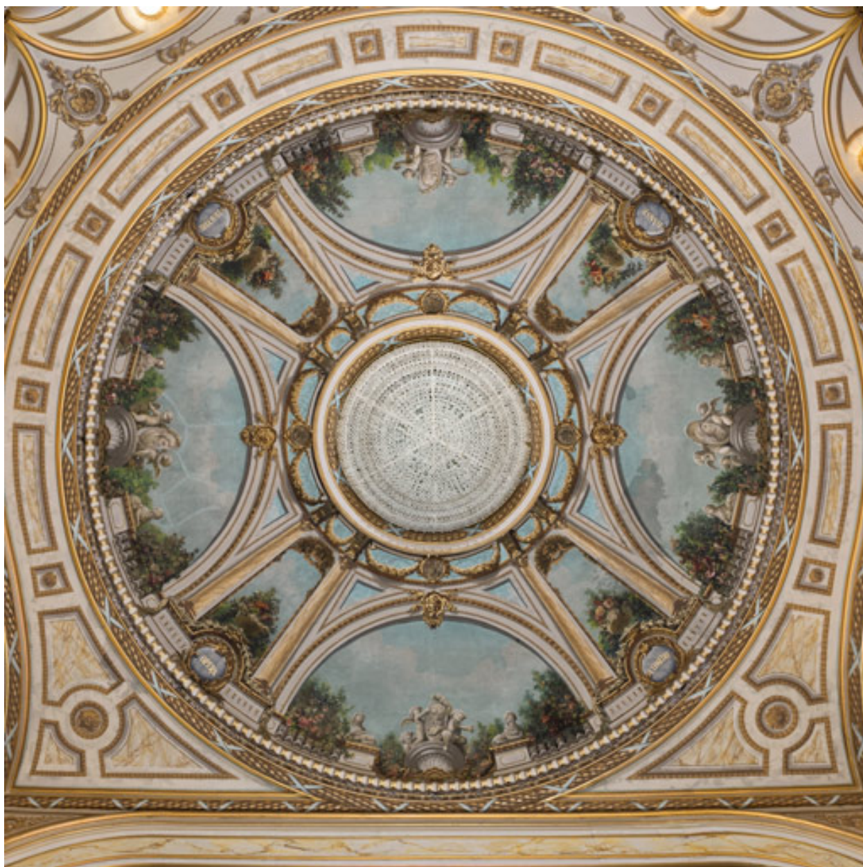
Plafond : vue d'ensemble.
