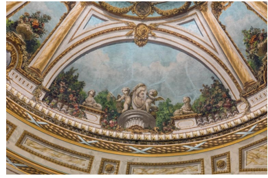
Plafond : décor du secteur côté jardin. Phot. Pierre-Marie Barbe-Richaud IVR26_20222100628NUC4A
