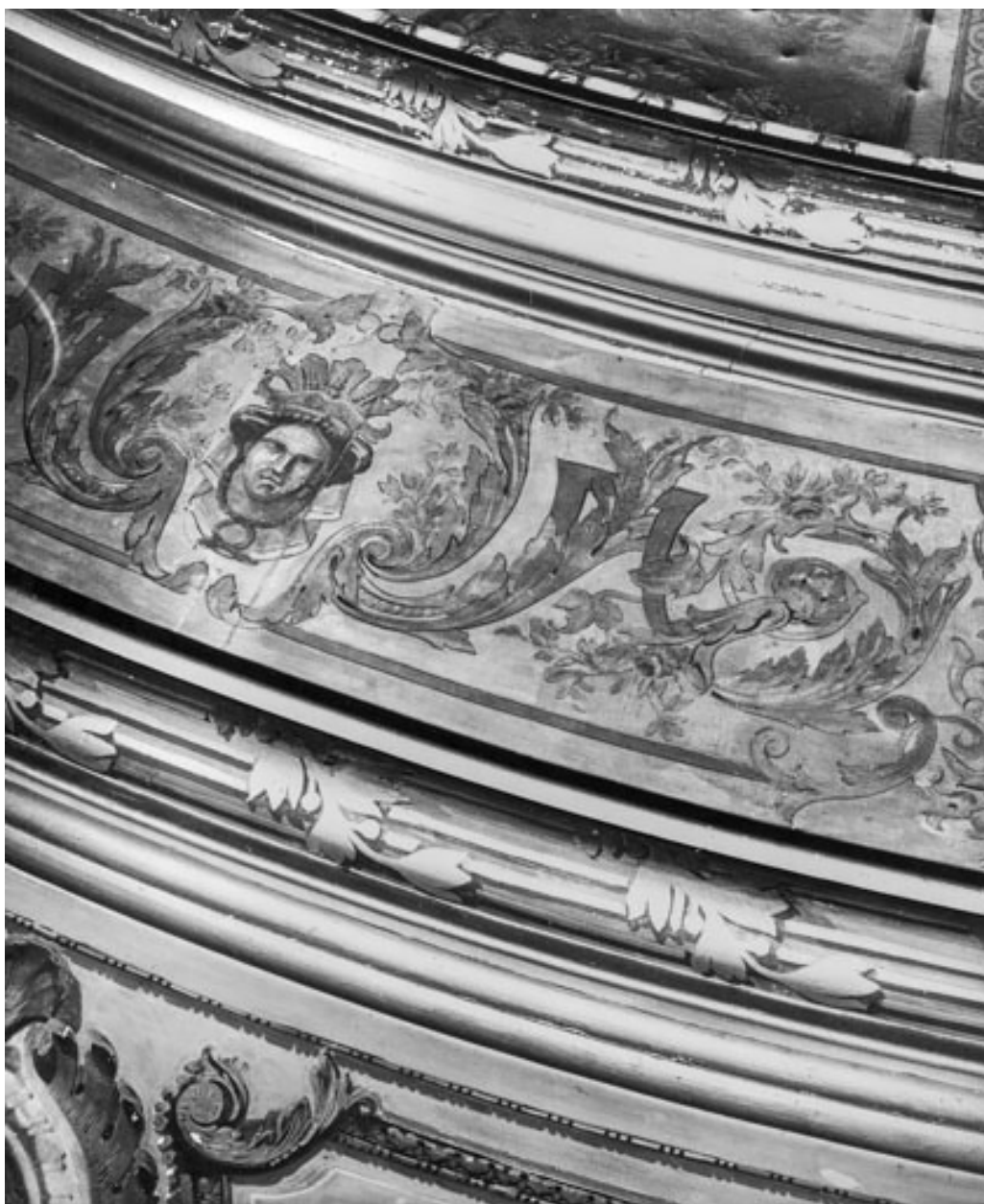
Détail plafond [avant travaux]. S.d. [1969].
