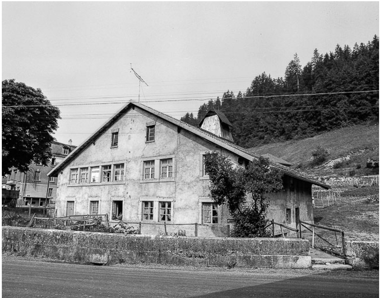
Ferme située 1 Grande Rue : façades antérieure et latérale droite.
