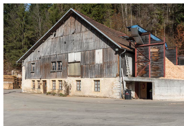
Ancienne scierie. Phot. Sonia Dourlot IVR43_20172501792NUC4A
