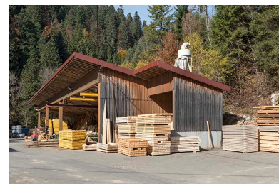
Ateliers à l'ouest. Phot. Sonia Dourlot IVR43_20172501791NUC4A
