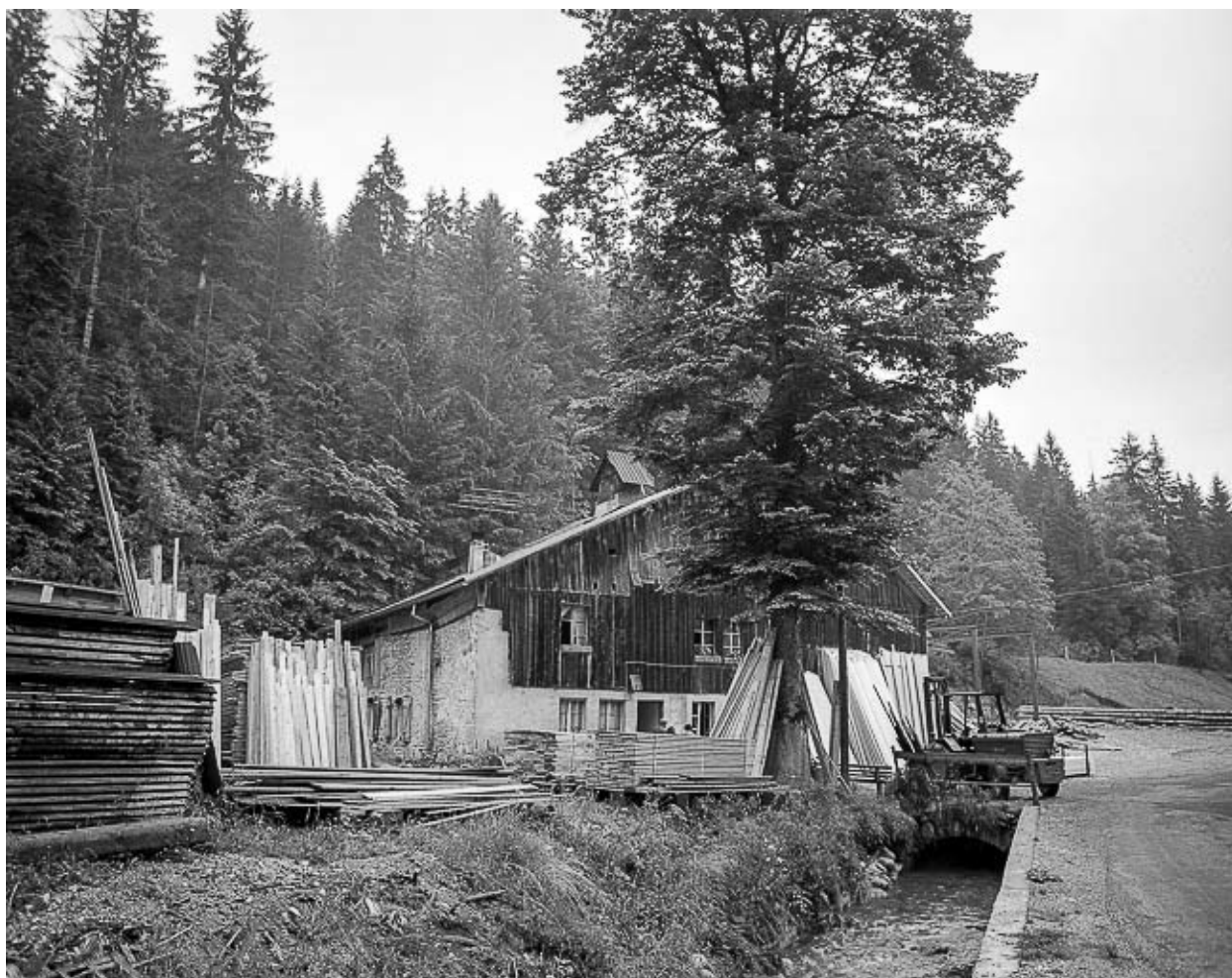
La scierie vue du sud-ouest, en 1976.
