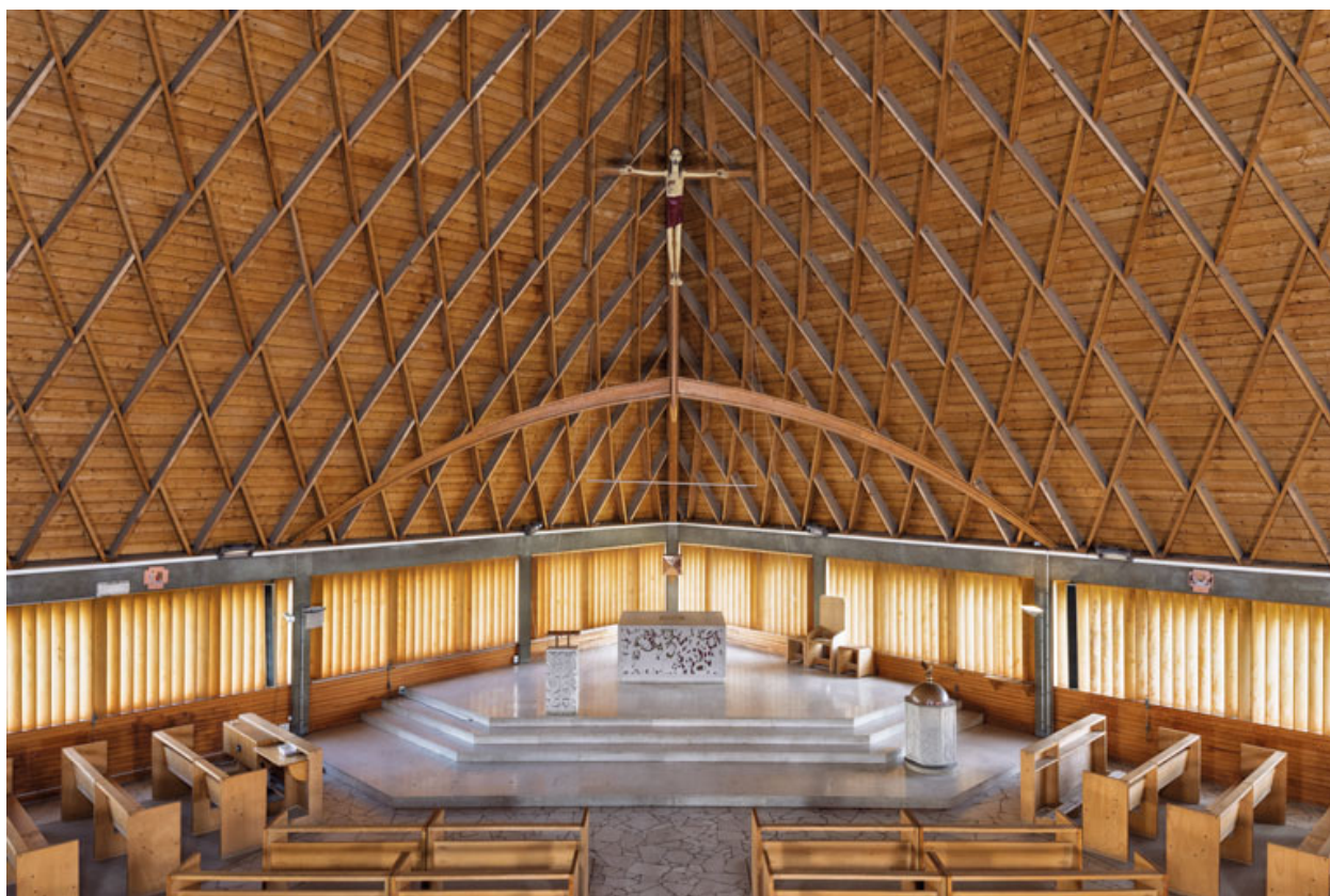
Poutre de gloire. Vue d'ensemble.
