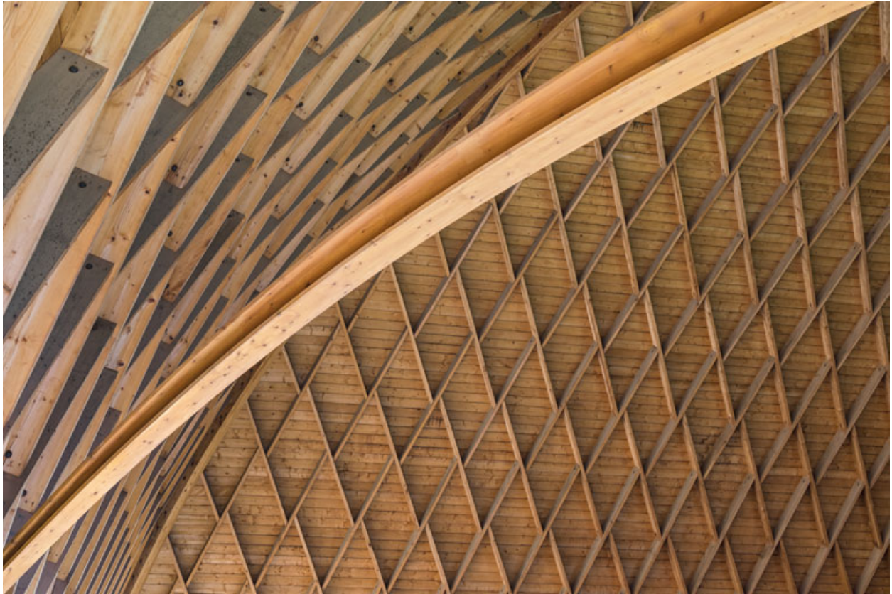
Poutre de gloire. Détail.
