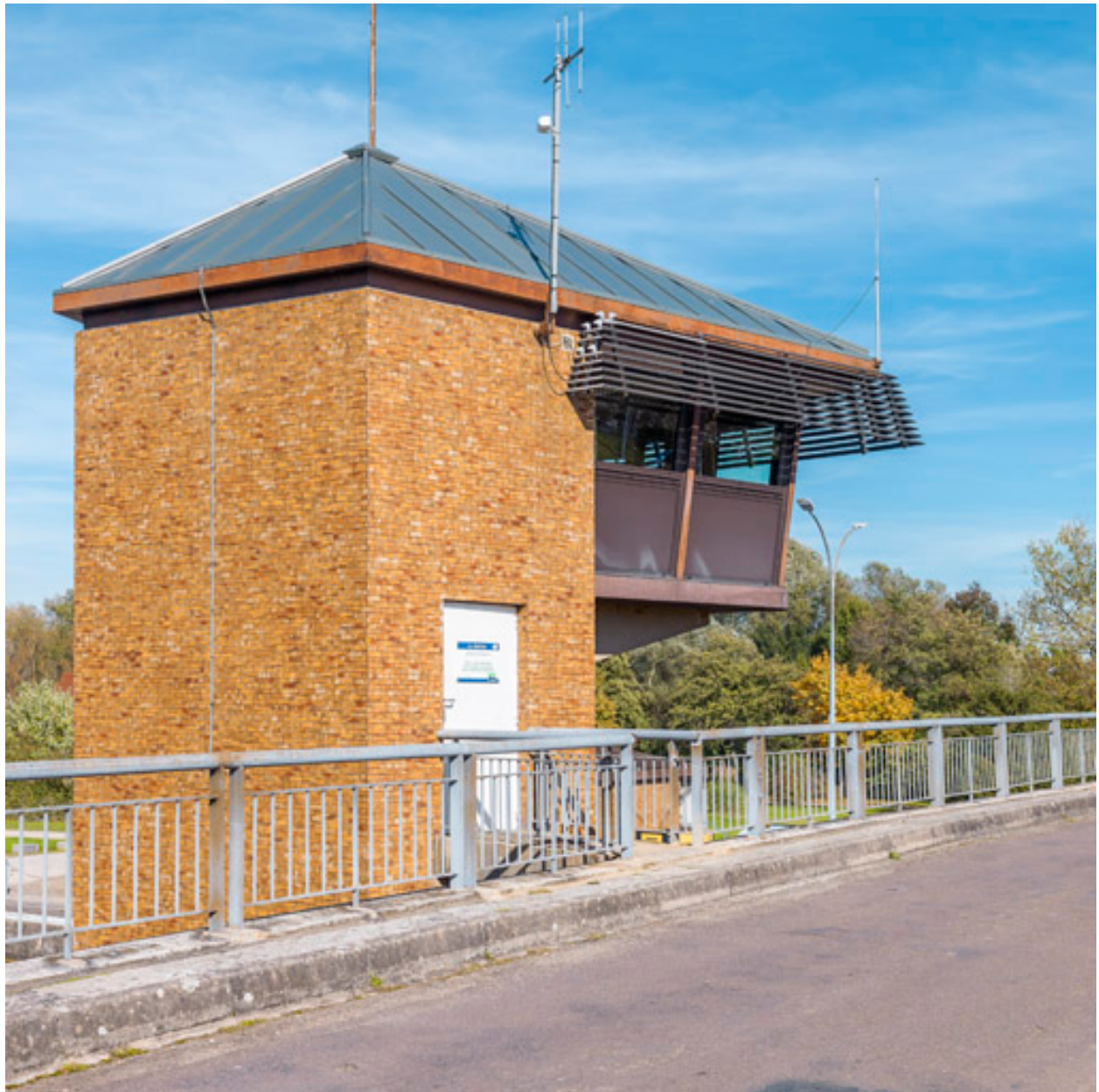
Vue rapprochée de la tour de contrôle.
