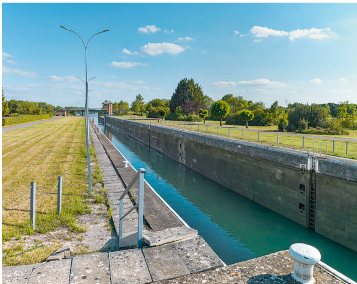
Vue d'ensemble du sas.
