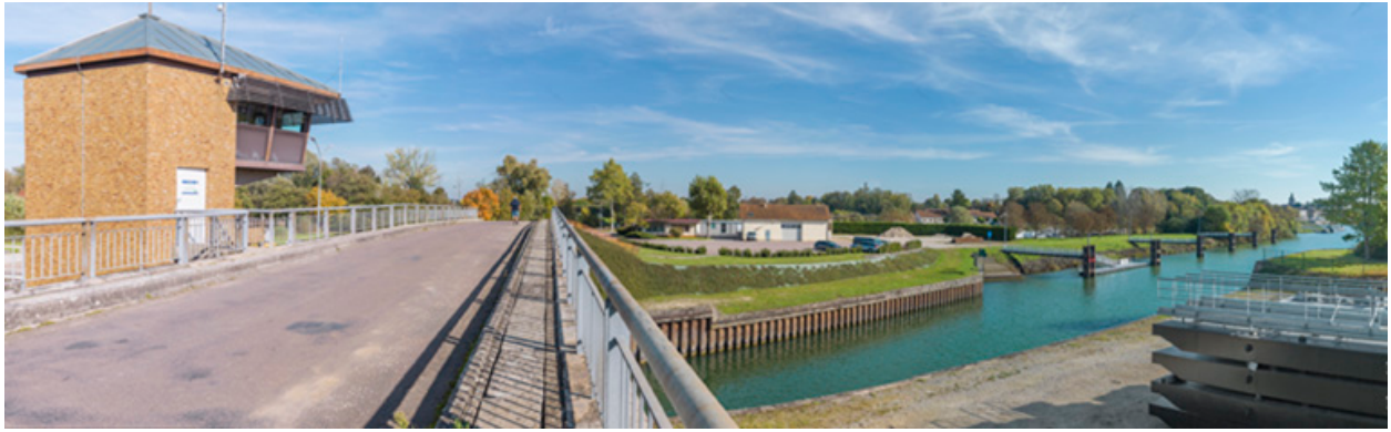
Pont sur le site d'écluse de Seurre.
