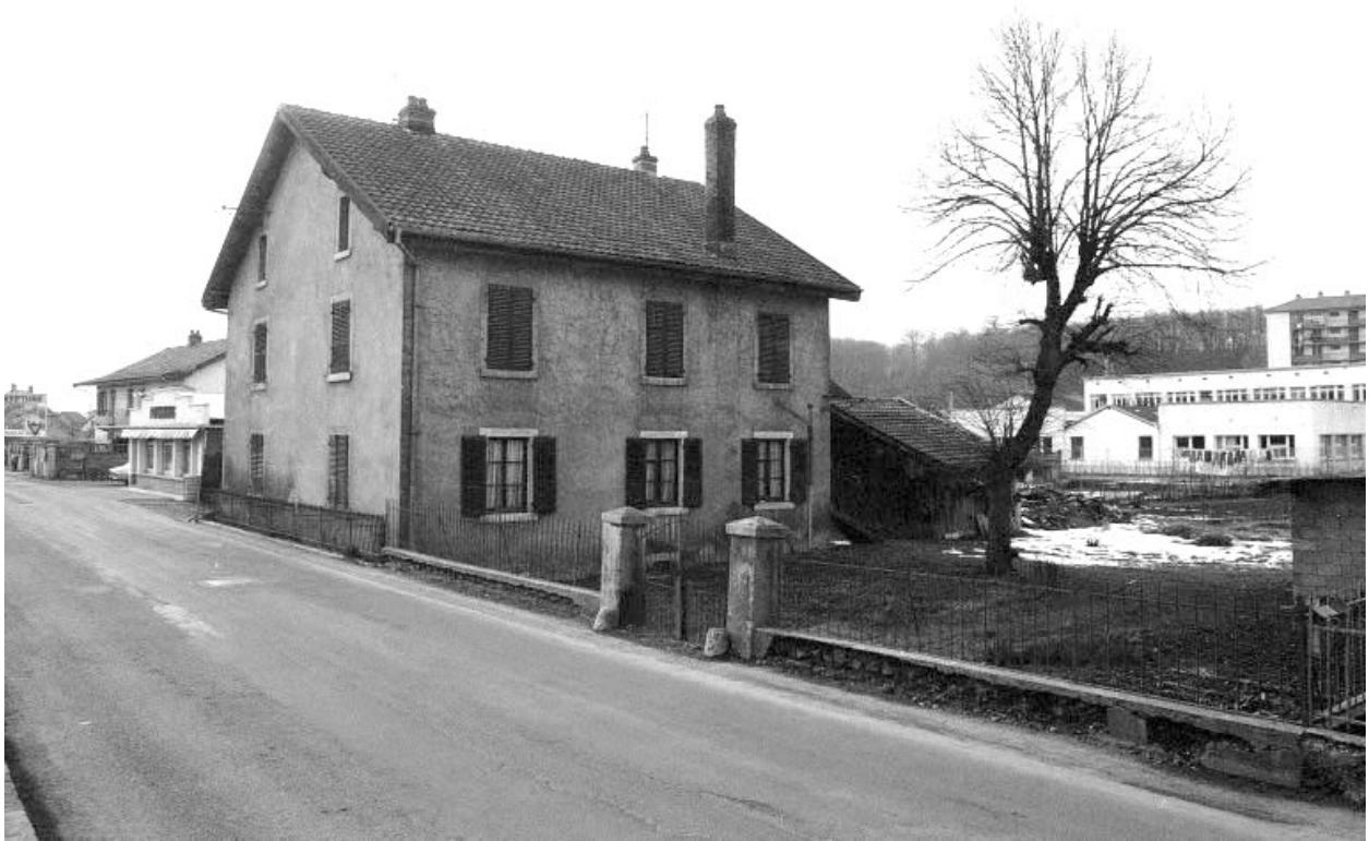
Façades postérieure et latérale droite.
