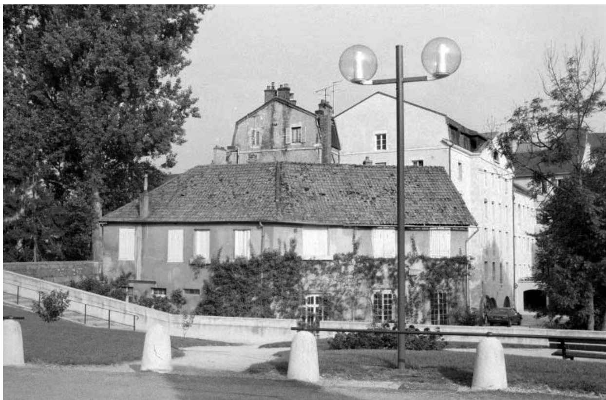
Atelier de réparation et bureau, depuis l'est.
