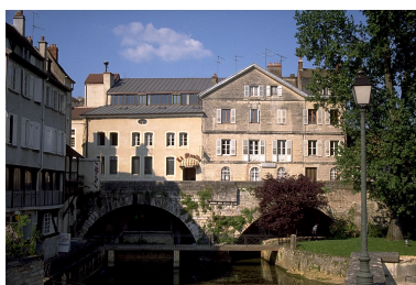
Façade antérieure. Phot. Laurent Poupard IVR43_19893900136ZA
