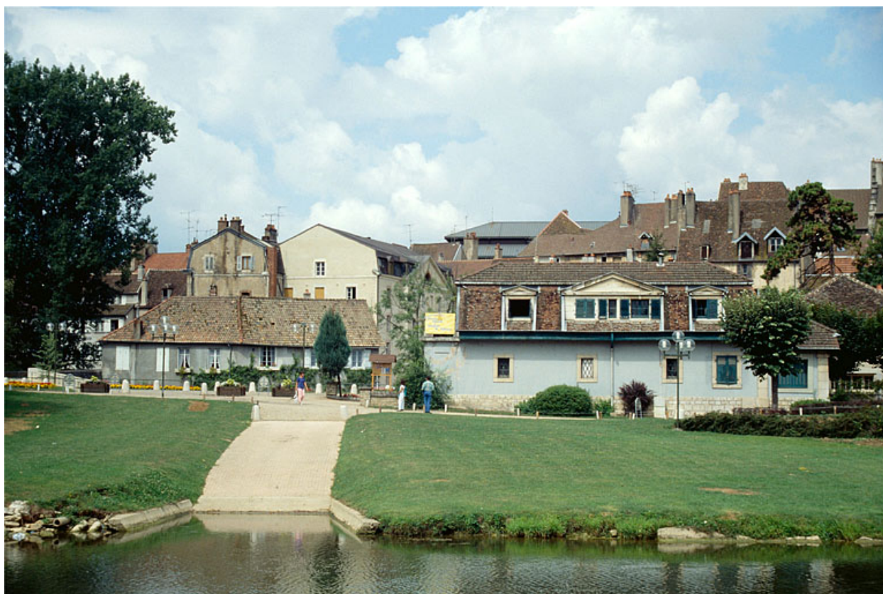
Bureau et logement d'ouvriers (H), depuis l'est.
