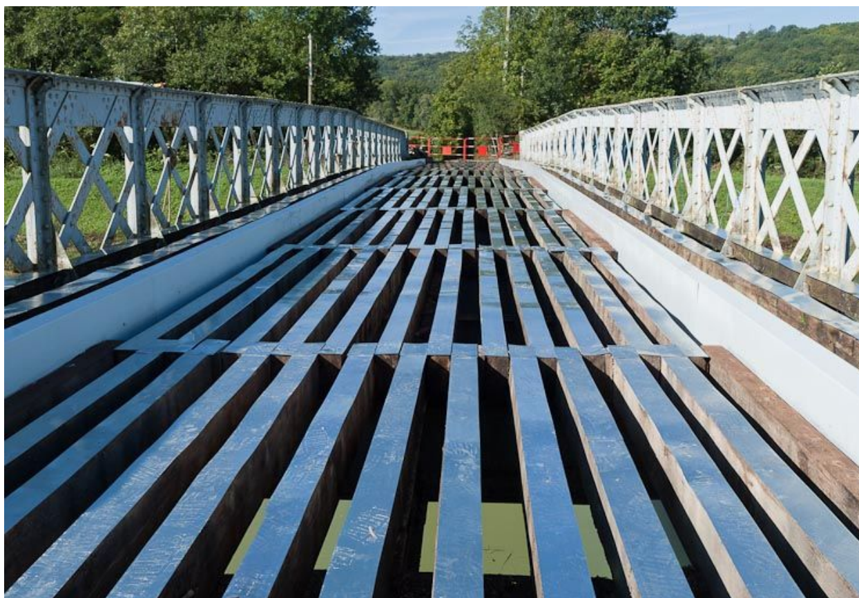
Vue du tablier pendant les travaux.
