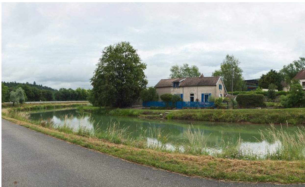
Vue de la maison de garde.
