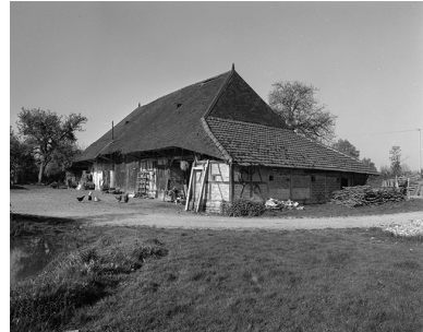
Bâtiment d'exploitation. Phot. Bernard Lardière IVR43_19793900313X
