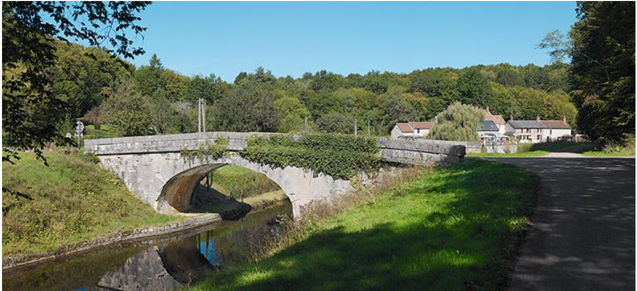
Vue d'ensemble du pont.
