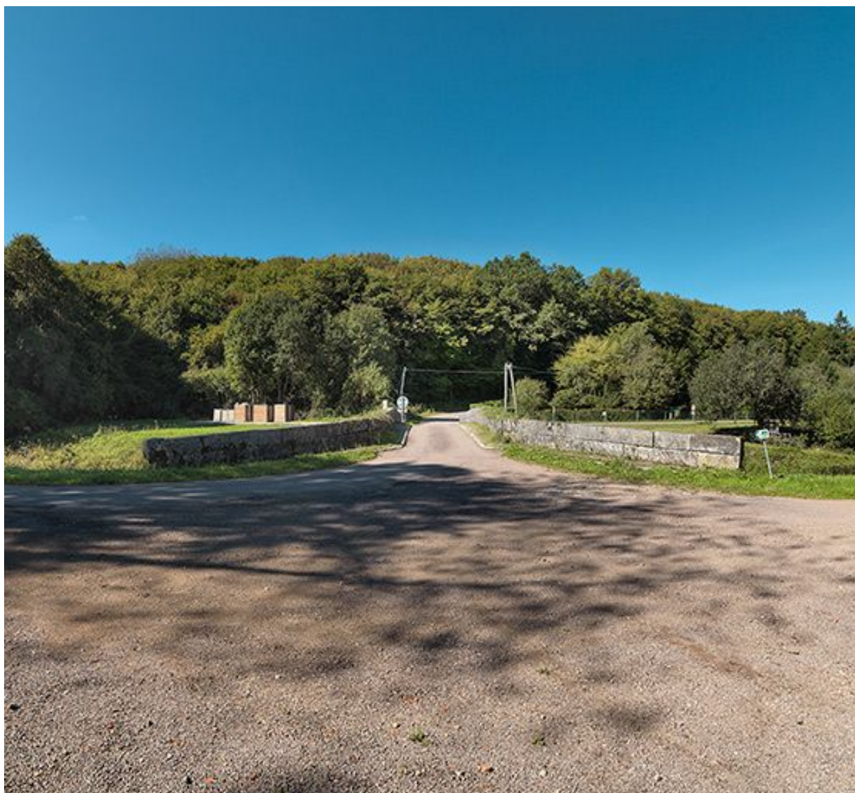
Vue d'ensemble du pont, avec les parapets.
