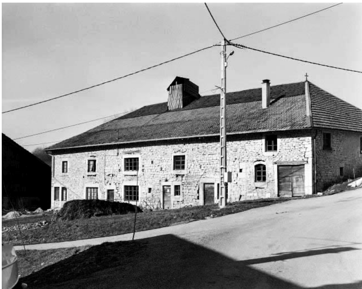
Façades antérieure et latérale droite.
