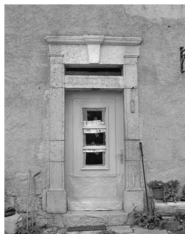
Les piédroits et le linteau de la porte d'accès. Phot. Yves Sancey IVR43_19993900319X
