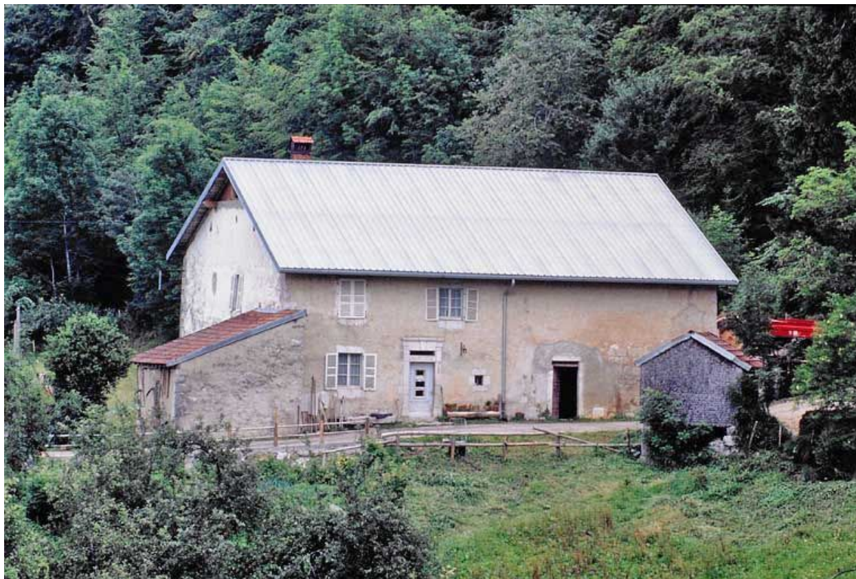
Vue éloignée de la façade antérieure.
