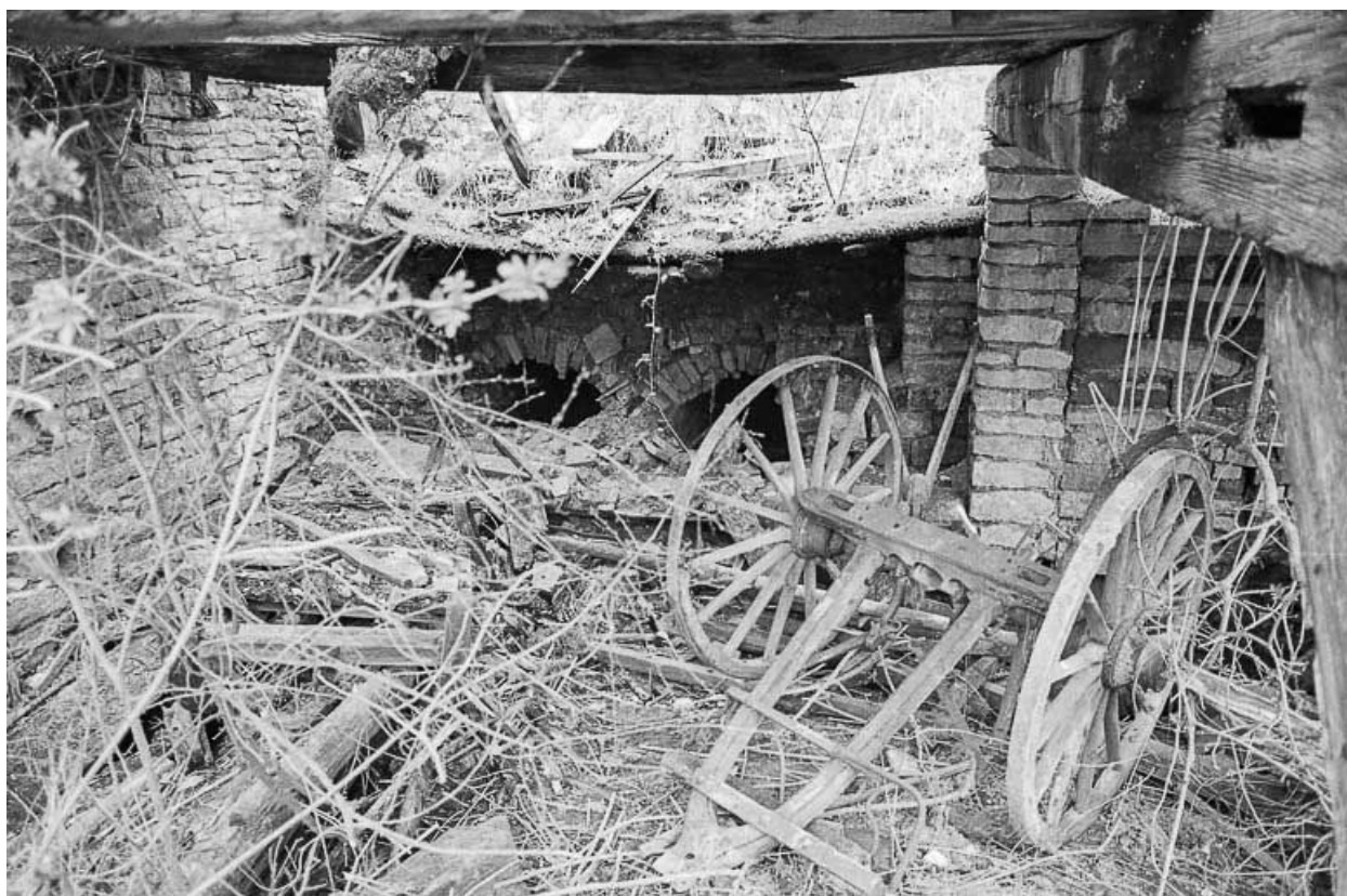
Bâtiment A : les fours.
