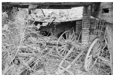
Bâtiment A : les fours. Phot. Jack Dumont IVR43_19797000446Z
