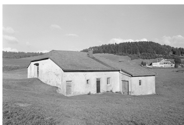
Façade antérieure et face nord-ouest. Phot. Jérôme Mongreville IVR43_19963901556X
