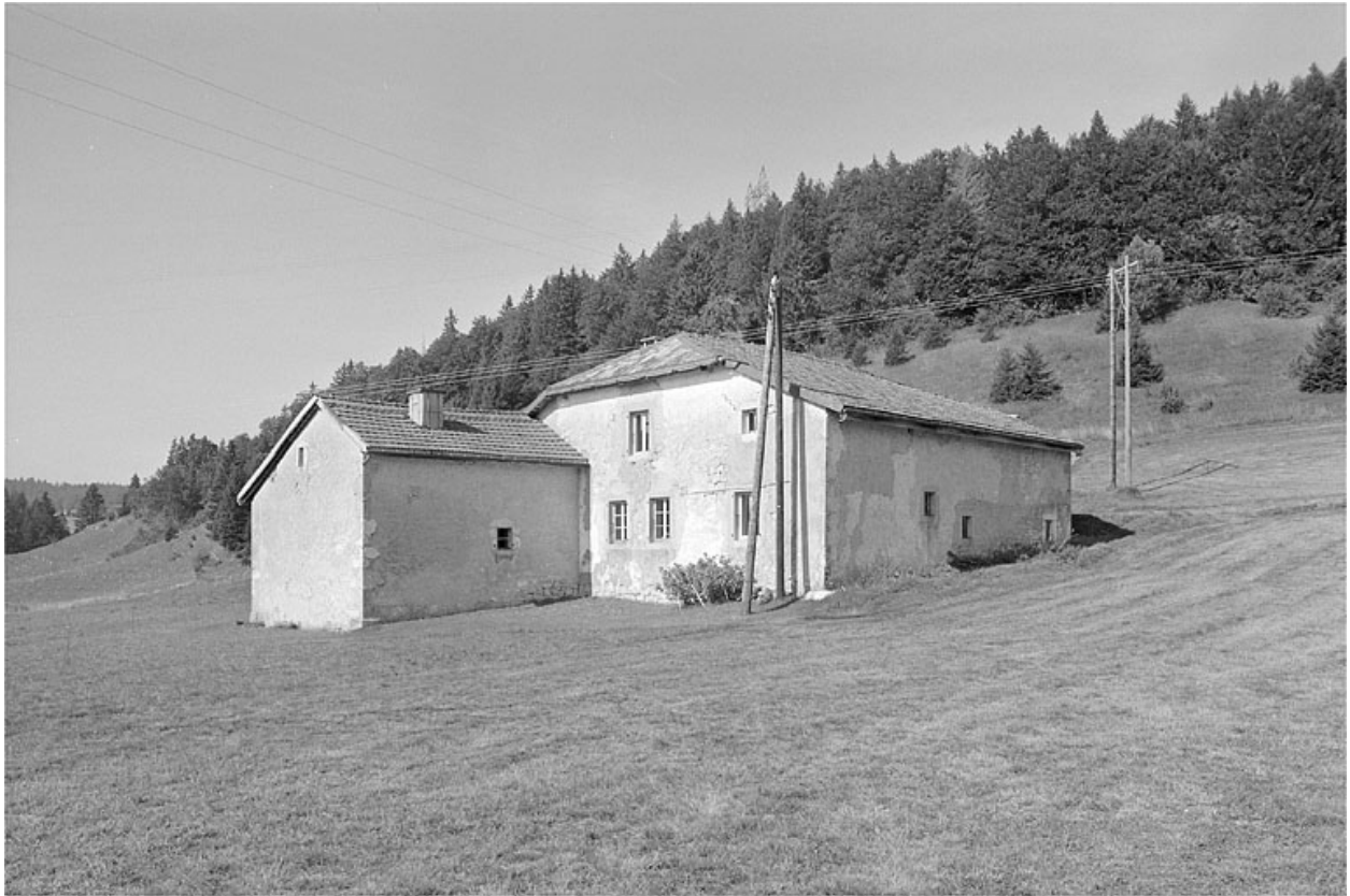
Face sud-est et façade postérieure.
