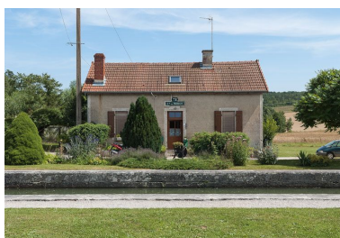
Maison éclusière, vue de face. Phot. Pierre-Marie Barbe-Richaud IVR26_20128900327NUC4AQ
