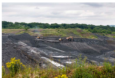
Front de taille de la carrière. Phot. Jérôme Mongreville IVR43_20152501366NUC4A
