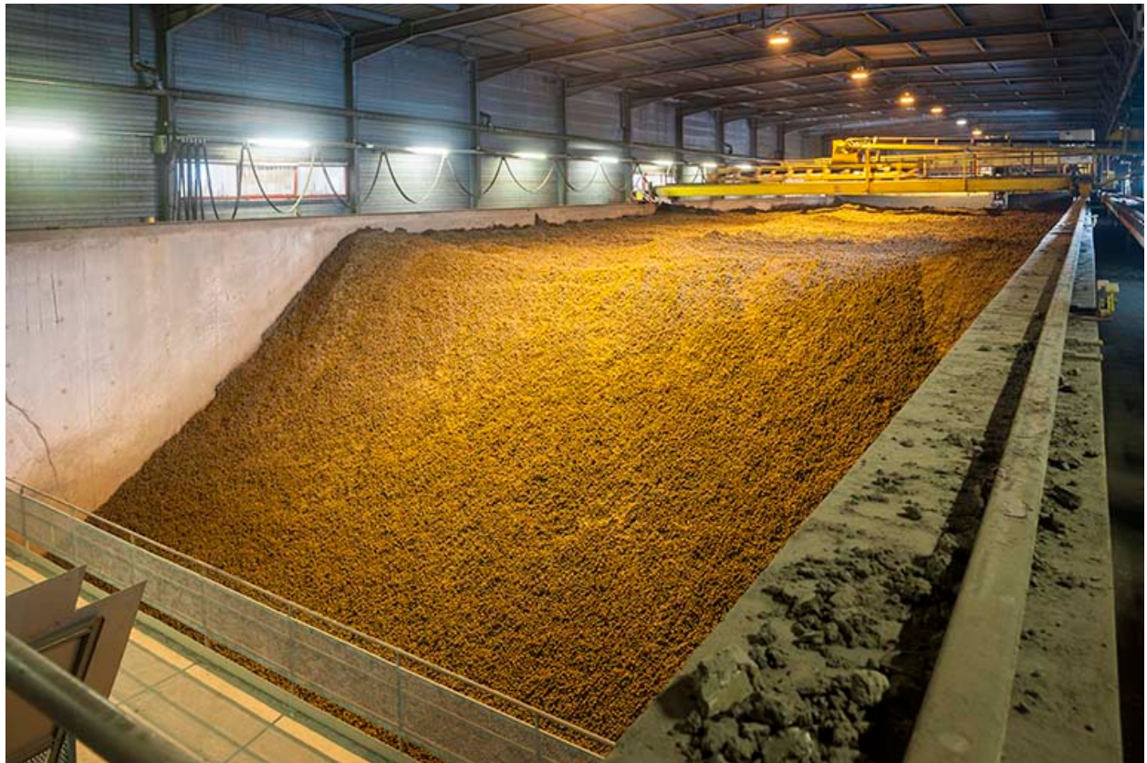
Fosse à terre (homogénéisation, maturation). Vue d'ensemble.
