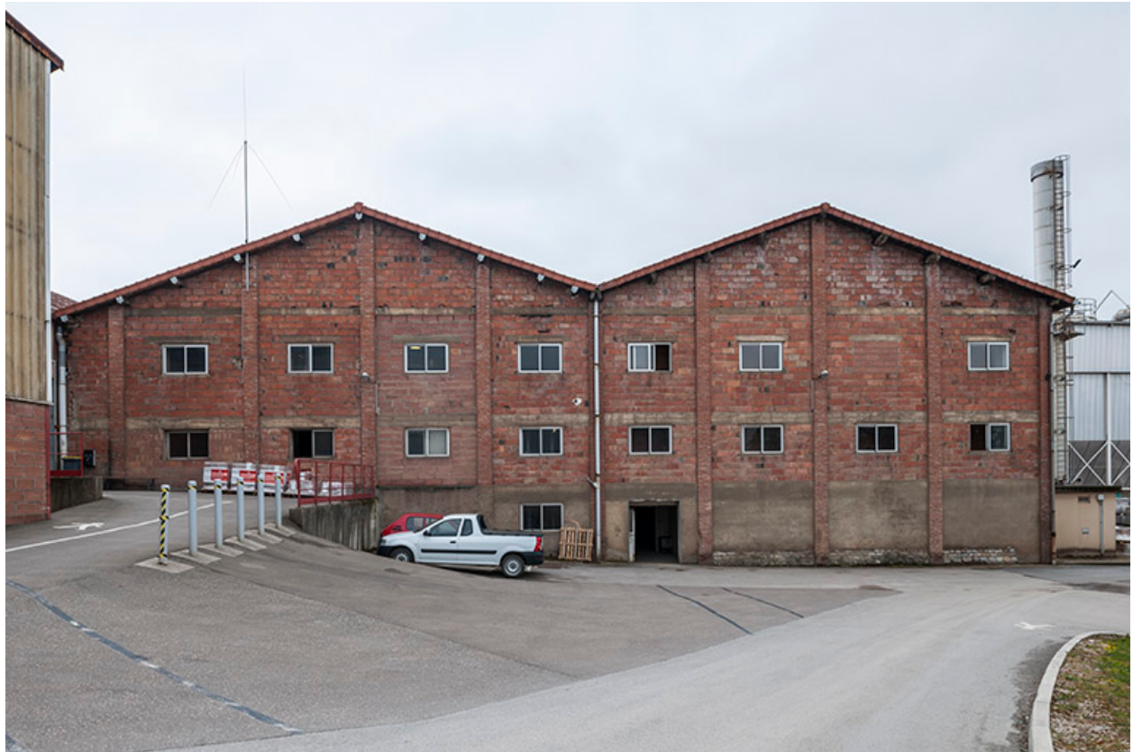
Murs-pignons de l'atelier de fabrication (actuellement UL 3).
