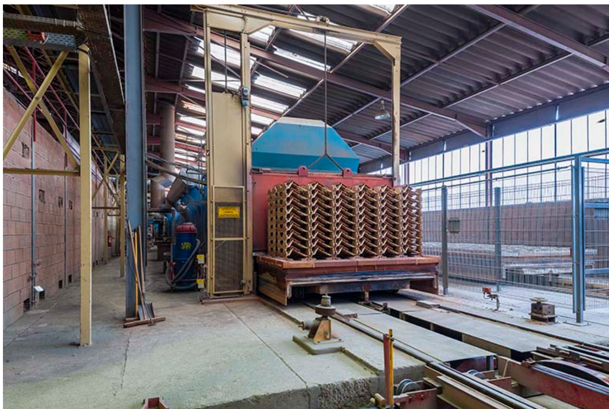
Unité de fabrication dite UL 1. Four (1984).
