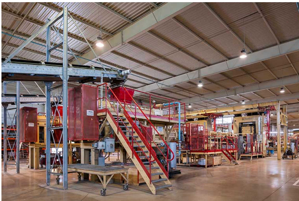
Unité de fabrication dite UL 5. Vue d'ensemble.
