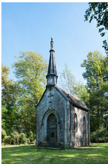
Vue générale nord-ouest Phot. Jérôme Mongreville IVR43_20137000426NUCA
