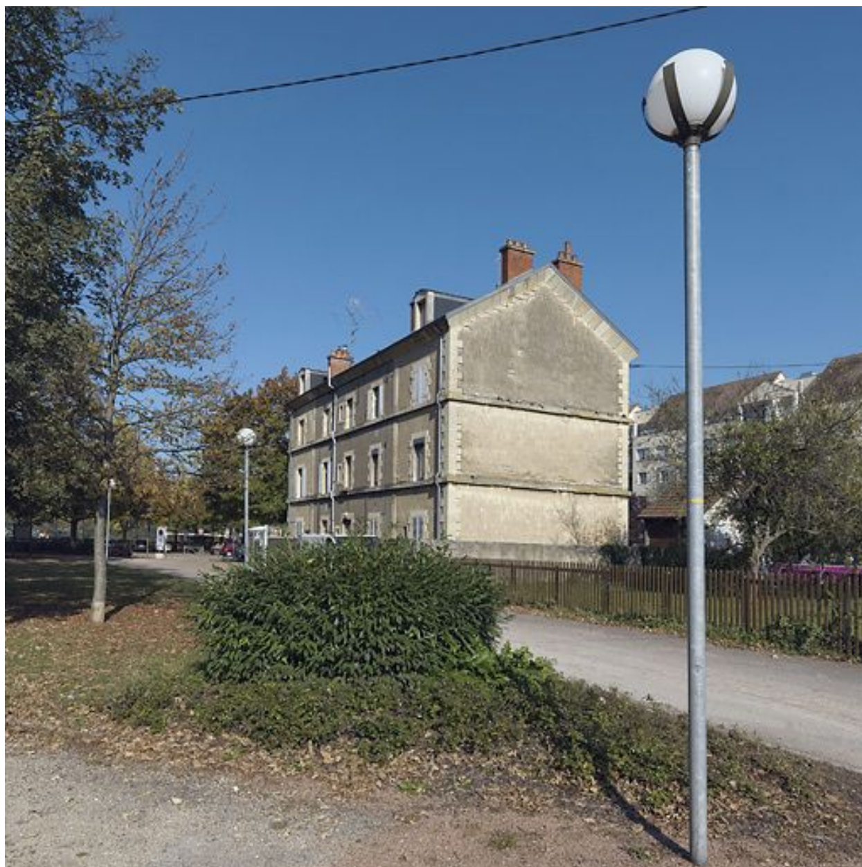
Façade sur port de la maison de perception : la différence de couleur d'enduit permet de repérer les travées ajoutées de part et d'autre du corps central.
